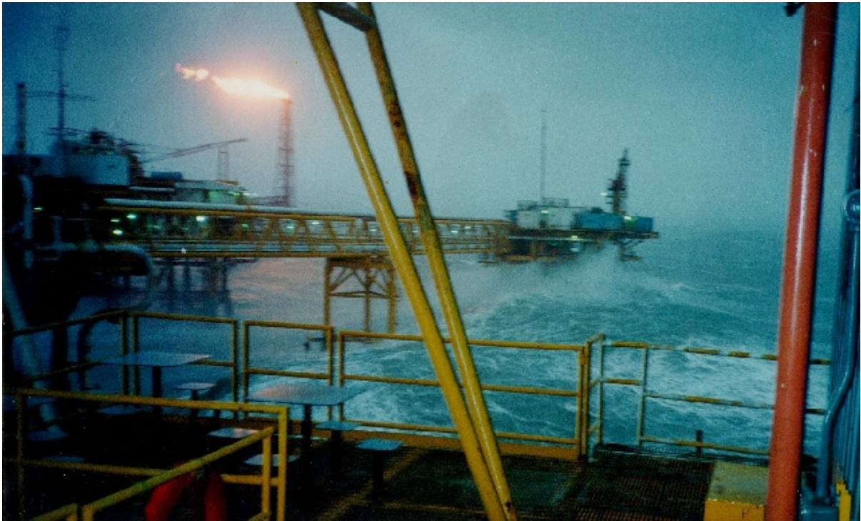
FIGURA 6.- IMAGEN DEL COMPLEJO DE PRODUCCIÓN ABKATUM-A, DE PEMEX EXPLORACIÓN Y PRODUCCIÓN, DURANTE EL PASO DEL HURACÁN ROXANNE. OCTUBRE 1995.
