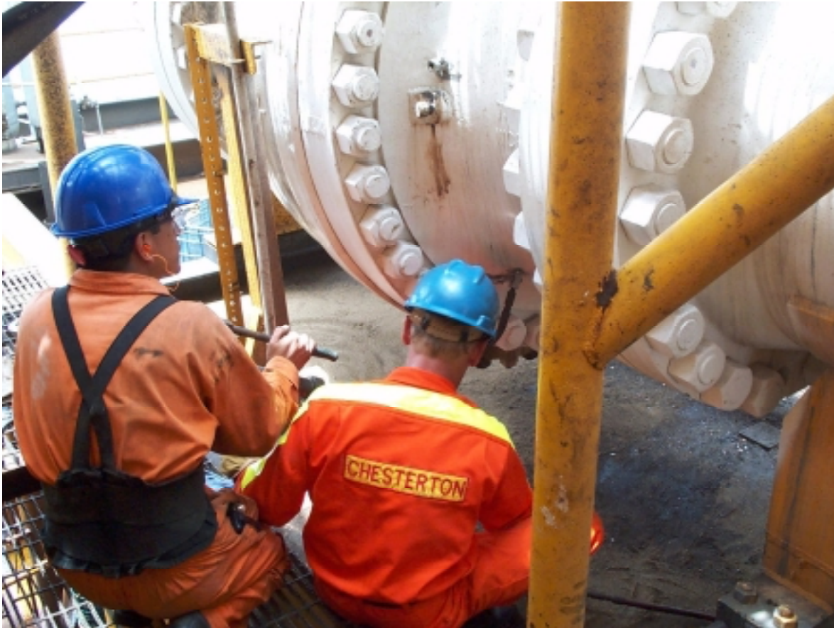
Fotografía 2.2 Inyección de grasa sellante a válvula de 36" Ø, por presentar fuga interna
