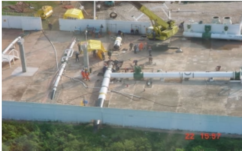
Fotografía 2.6 Retiro de segmentos de tubería y válvulas
