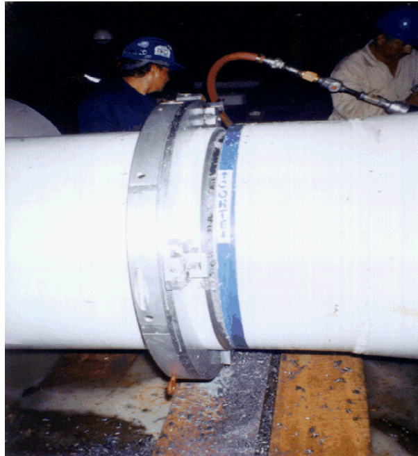
Fotografía 2.5 Corte en frío tubería de 36"Ø espesor de 1" bicel de 45° Tiempo 2 horas
