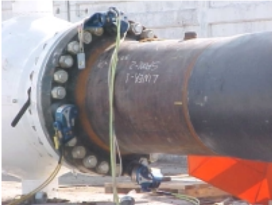
Fotografía 2.3 Equipo de apriete simultaneo controlado
