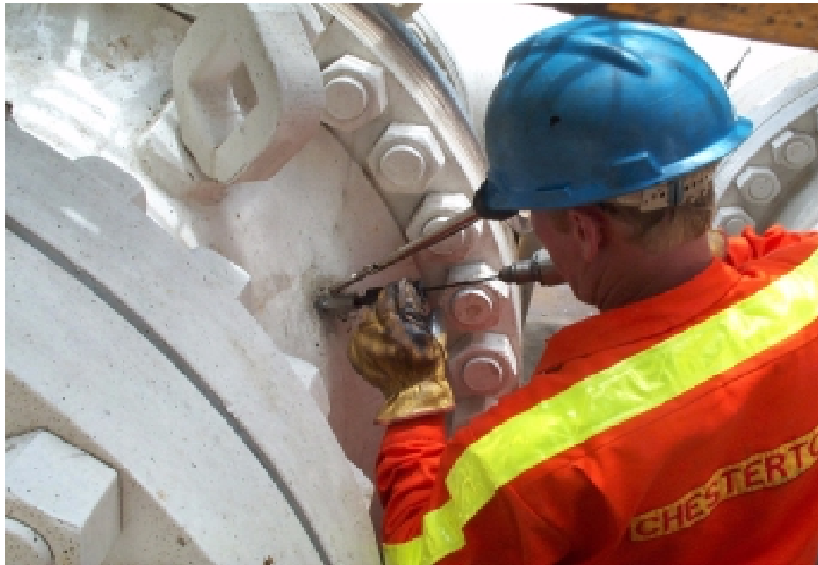
Fotografía 2.4 Construcción de puertos de inyección a válvula de 36" Ø
