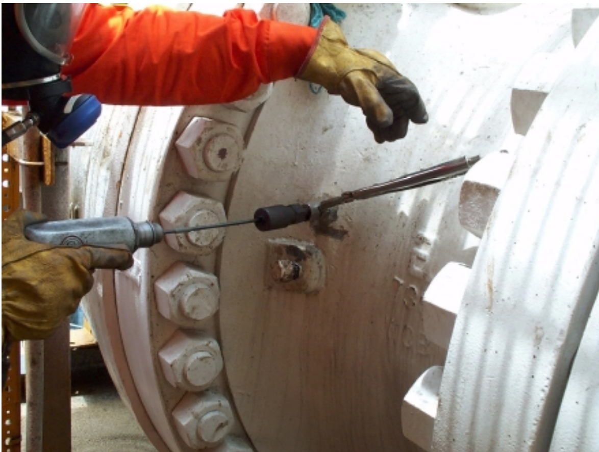
Fotografía 2.1 Construcción de puertos de inyección en válvula de 36" Ø ( Libranza del L-2)
