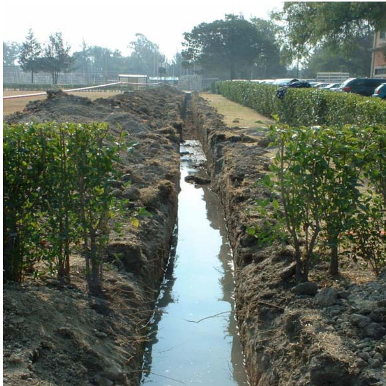
Figura No 21 Tramo 2, excavación para alojar tubería de PVC RD-26, primera etapa
