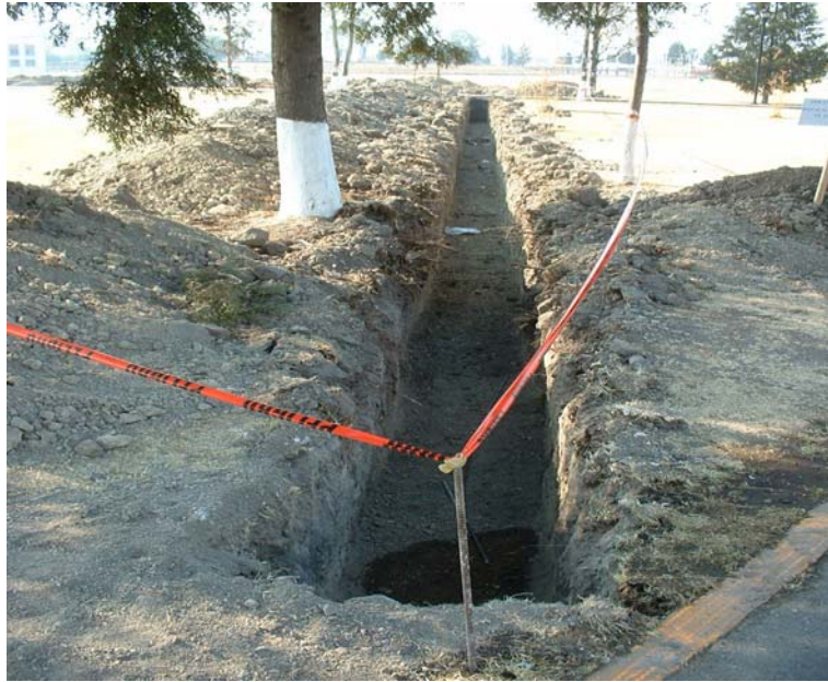
Figura No 21 Tramo 2, excavación para alojar tubería de PVC RD-26, primera etapa
