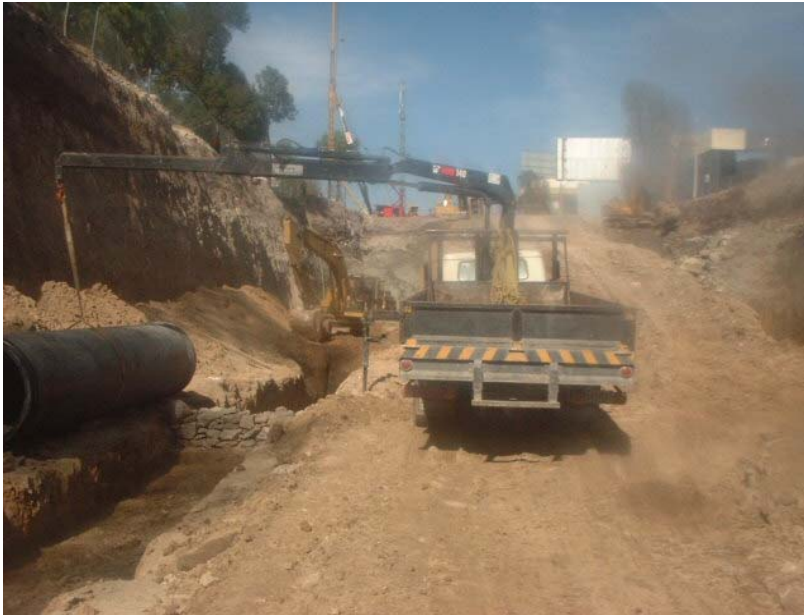
Figura No. 18 Colocación de tubería de polietileno con equipo
