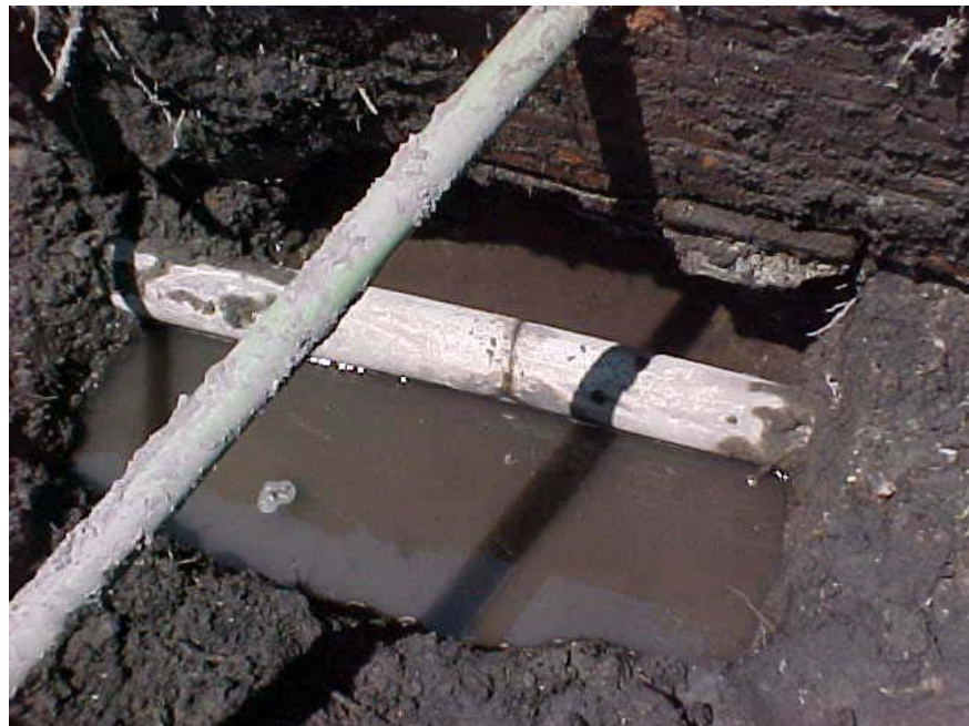
Figura No. 5 tubería con fuga en zona residencial 4
