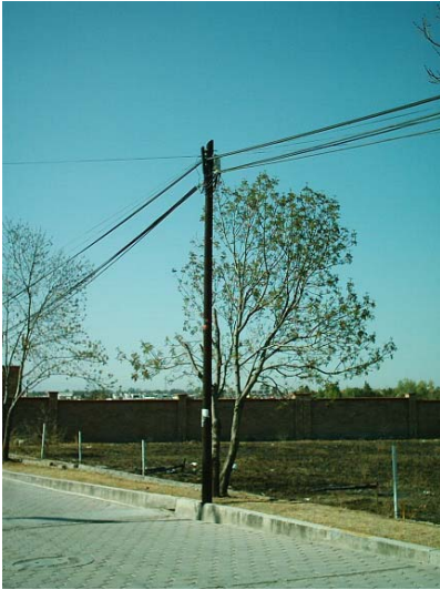
Foto 44.- Poste de teléfono
