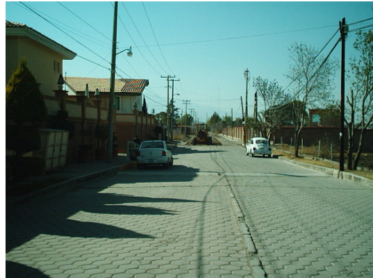
Foto 41.- Acceso Norte (calle 14 Oriente)
