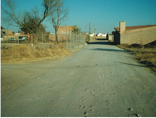
Foto 53.- Calle sin Pavimentos, ni guarnición
