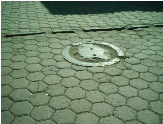
Foto 46.- Drenaje y adoquín
