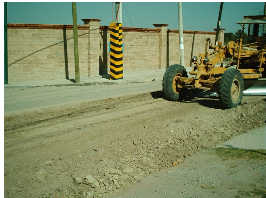
Foto 47.- Calle en proceso de adoquinado
