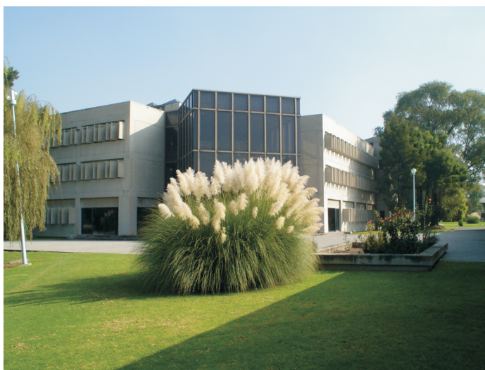
Figura 3. Vista general del edificio de aulas del Colegio de Postgraduados, Campus Montecillo, en Texcoco, Estado de México.
