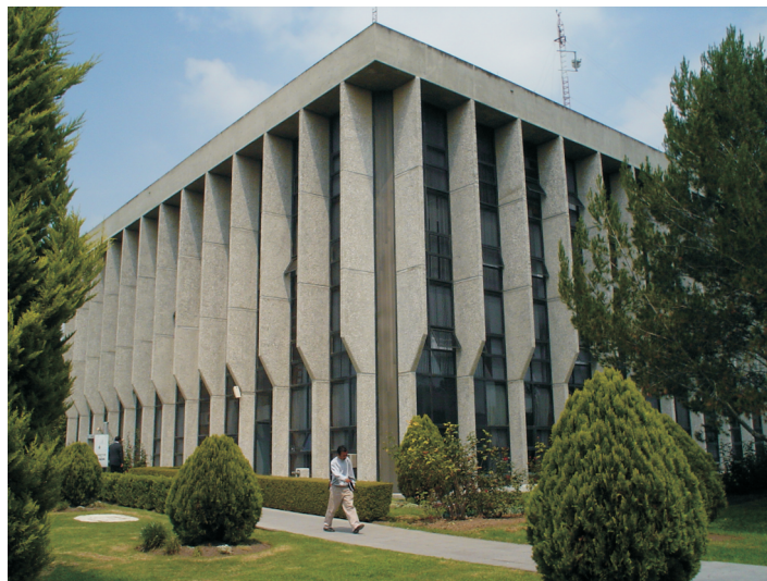
Figura 1. Vista general del edificio de gobierno del Colegio de Postgraduados, Campus Montecillo, en Texcoco, Estado de México.
