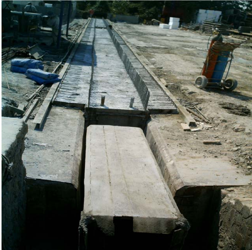
Figura 3.7.3 Colado de Viga cajón
