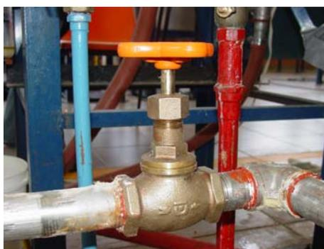
Figura 7.20 Válvula de globo para control de flujo
