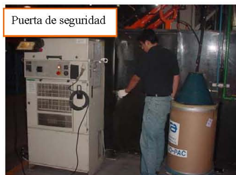
Figura 2.23.- Puerta de la celda.
