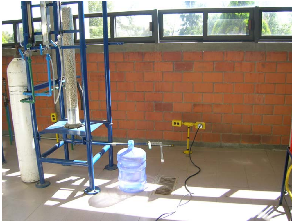
Figura H.7. Toma de corriente para el intercambiador.
