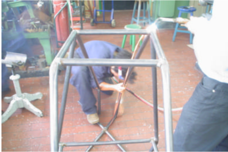
Figura 6. 22 Calentamiento de la Estructura para su Preforma.
