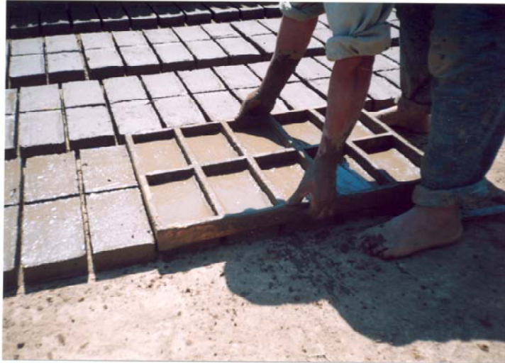
Figura 18. Liberación de los ladrillos de la rejilla.
