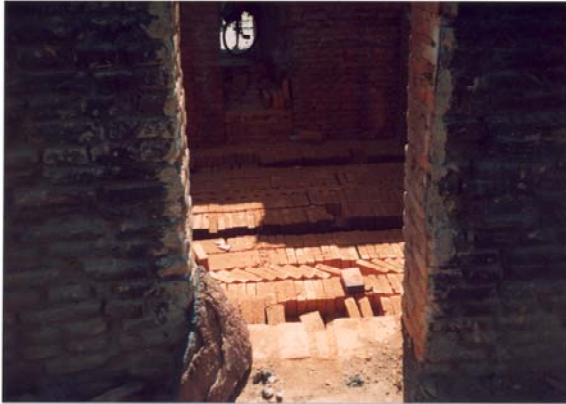
Figura 14. Vaciado del horno.
