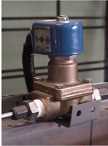
Fig. 10.20 Válvula solenoide.
