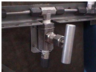
Fig. 10.19 Válvula de aguja.
