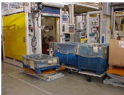
Figura 4.7. Soldadora automática para la Operación 90
