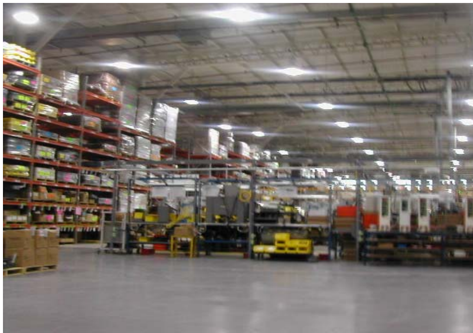
Figura 1.5 Nave industrial-“Interruptores eléctricos”
