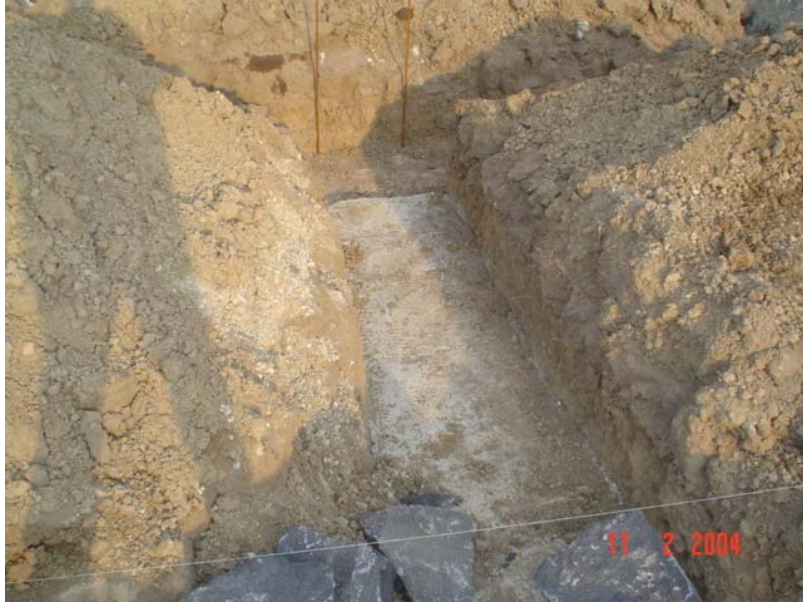
Figura 3.10 Plantilla de cimentación.
