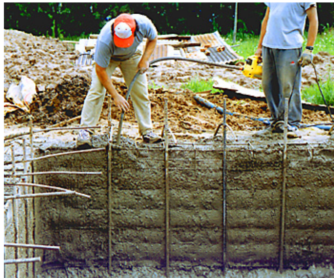
Figura 3.12 Vibrado del concreto.
