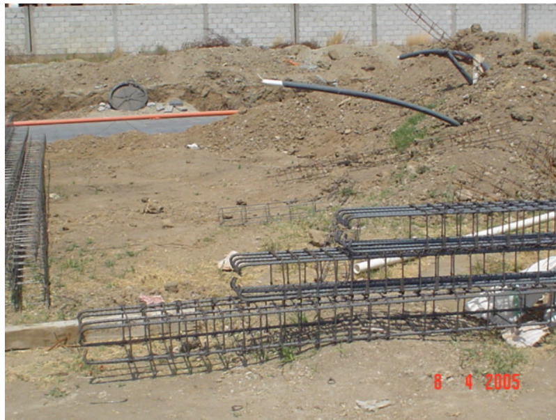
Figura 3.14 Armado de Acero.
