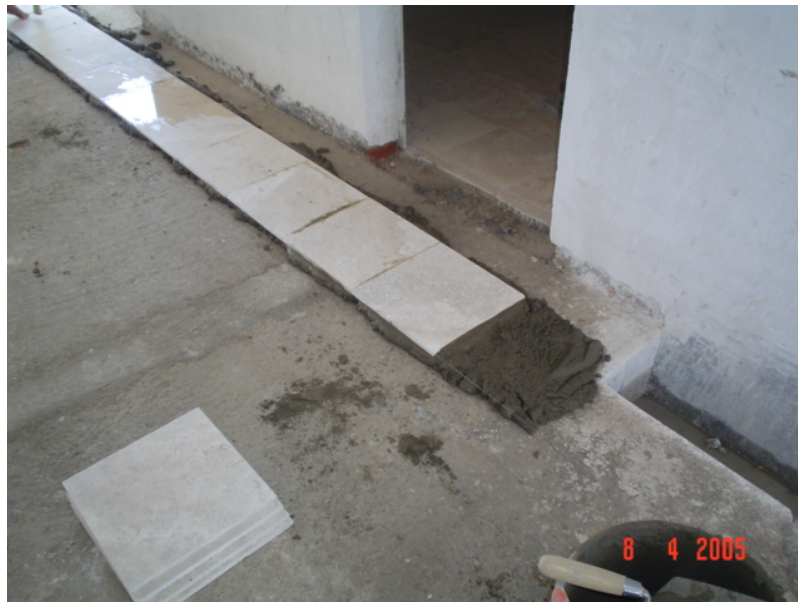
Figura 3.20 Colocación de mármol.
