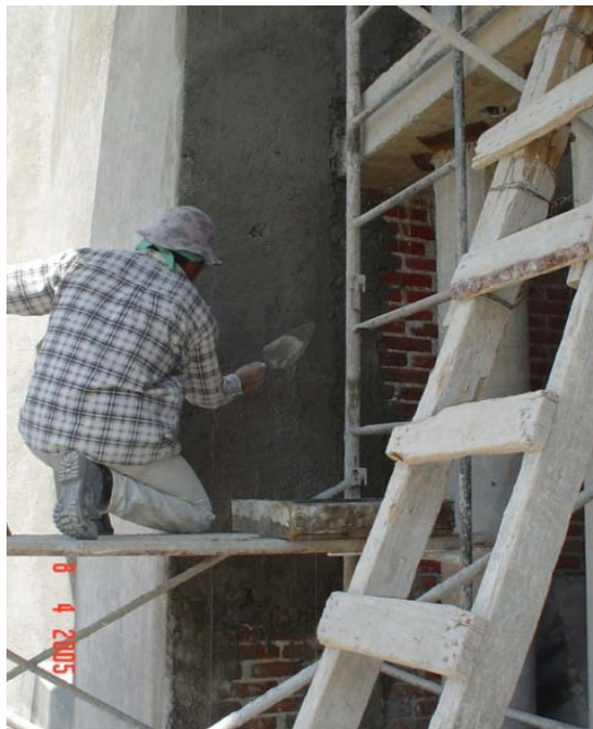
Figura 3.19 Aplanado en muros.
