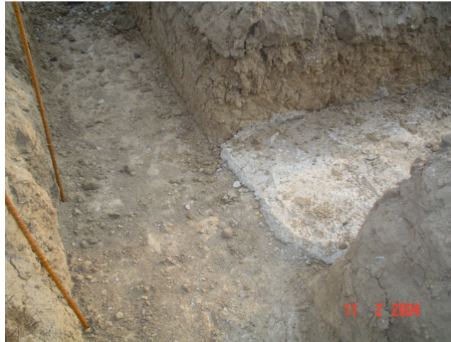
Figura 3.9 Excavación de cepas de cimentación.
