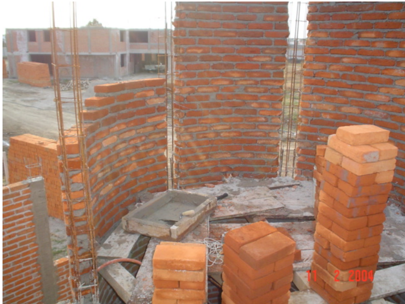
Figura 3.31 Desplante de muros de tabique.
