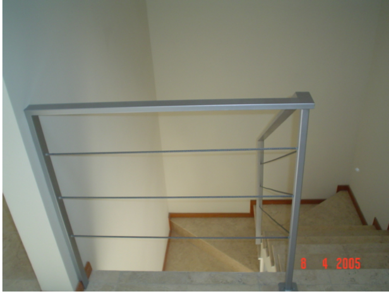
Figura 3.27 Barandal en escalera casa modelo San Ángel
