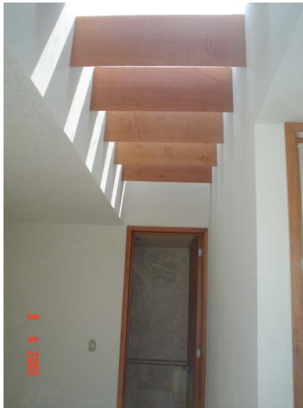
Figura 3.33 Vigas de madera en domos casa modelo San Ángel.
