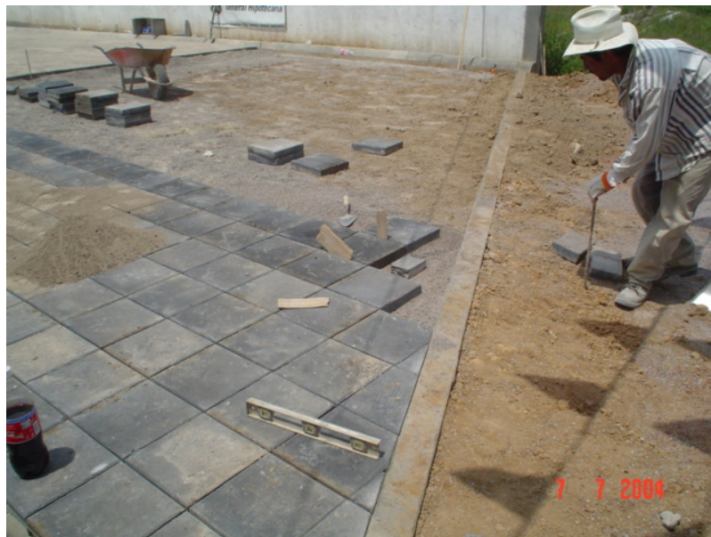
Figura 3.2 Colocación de adocreto.
