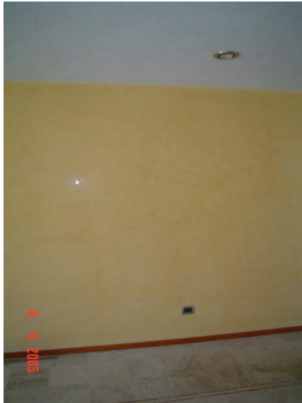
Figura 3.29 Acabado Palladium Sala Comedor Casa modelo San Ángel
