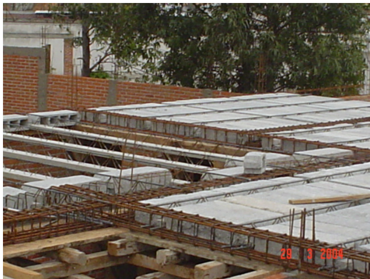
Figura 3.18 Losa prefabricada (vigueta y bovedilla)
