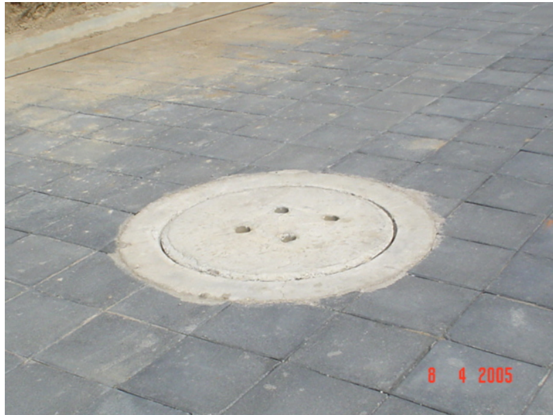
Figura 3.5 Pozos de visita.
