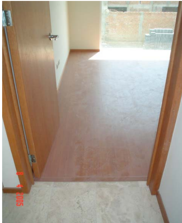
Figura 3.40 Piso laminado en recámara principal.
