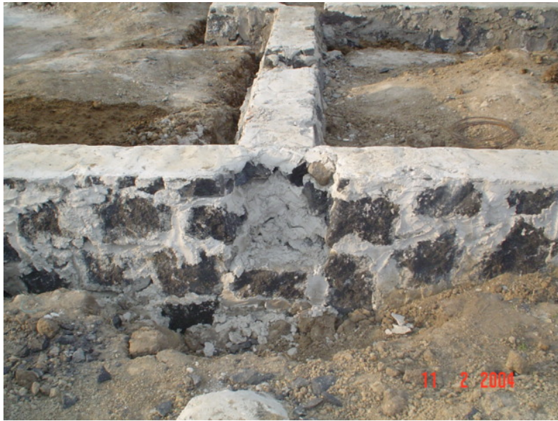
Figura 3.11 Cimentación de mampostería.
