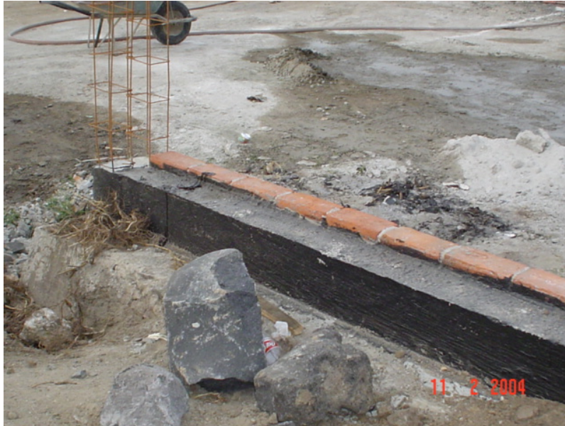
Figura 3.16 Impermeabilizado de cadenas de desplante.
