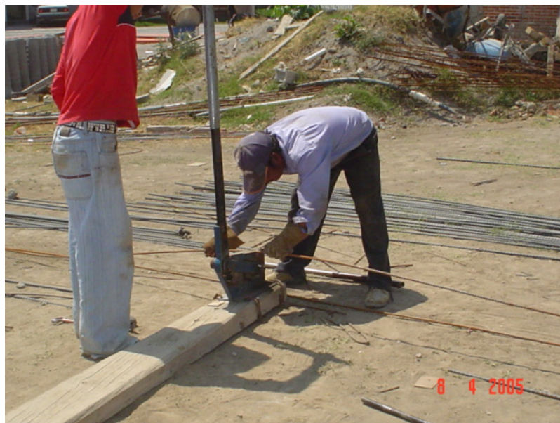
Figura 3.13 Acero de refuerzo.
