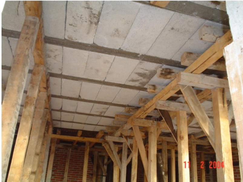
Figura 3.15 Cimbra de madera. (losa)
