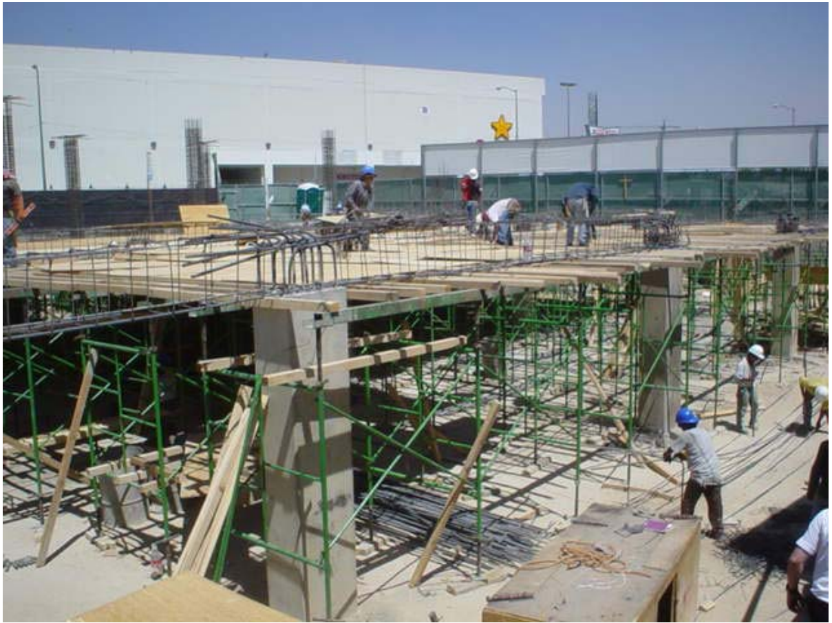
Fotografía F del cimbrado e inicio de armado de losa de sótano
