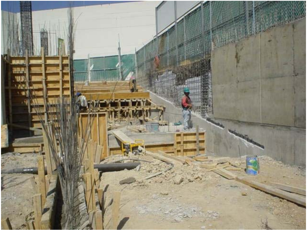
Fotografía C del cimbrado y armado de rampa
