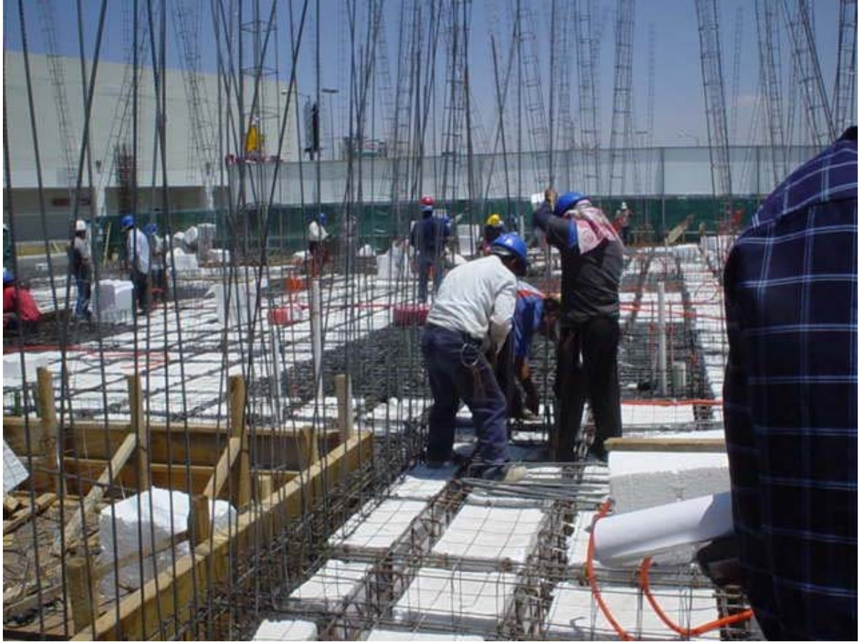
Fotografía D del armado de losa artesonada
