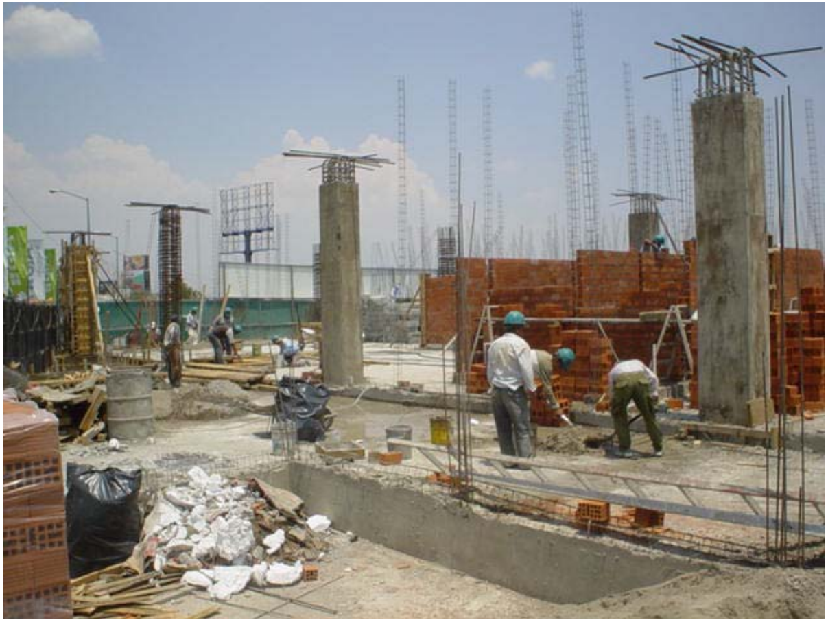
Fotografía E de albañilería de la primera planta tipo
