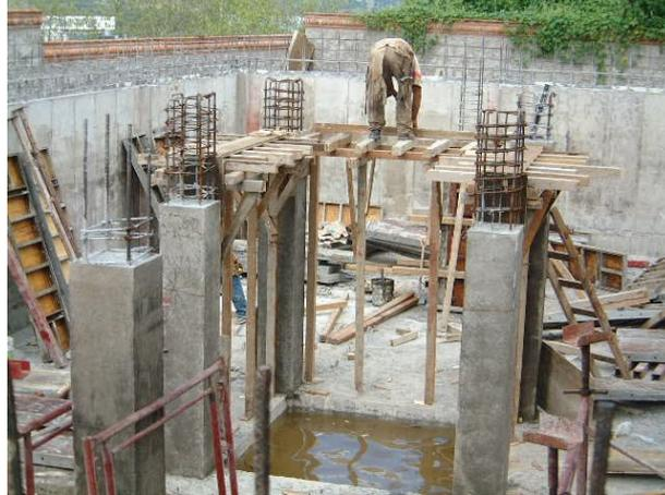
Figura. 3.1.26 Descimbrado muros, columnas e inicio cimbrado losa superior tanque regulador
