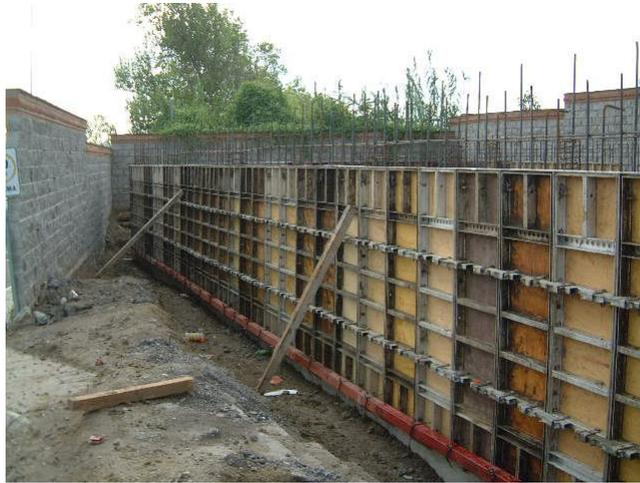
Figura. 3.1.20 Cimbrado y troquelamiento apoyado en el terreno.
