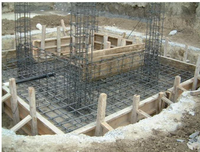
Figura 3.1.3 Armado cárcamo, losa de cimentación y tubo para desagüe
