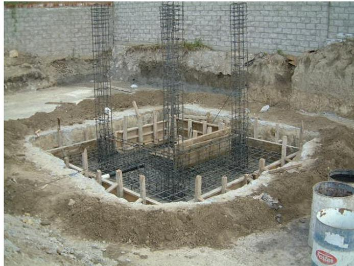
Figura 3.1.4 Armado columnas primera etapa
