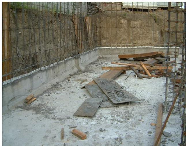
Figura. 3.1.18 Descimbrado losa inferior
