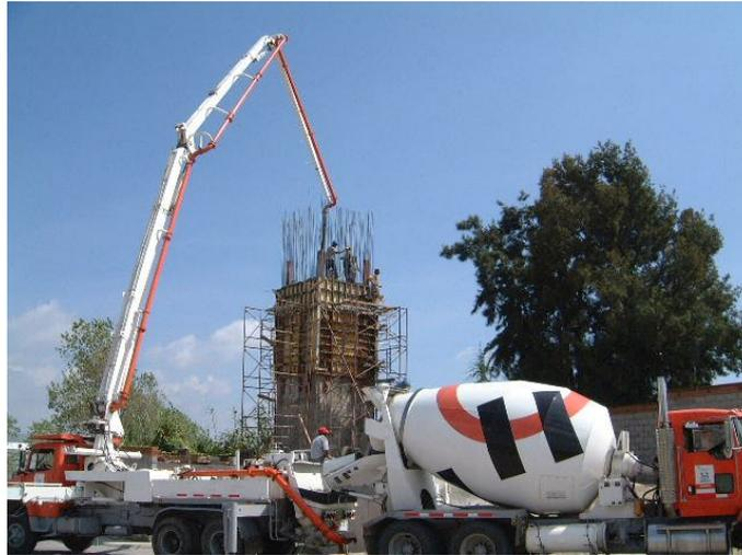
Figura. 3.2.3 Colado segunda parte muros soporte.
