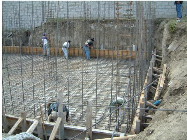
Figura. 3.1.11 Armado losa inferior y muro
