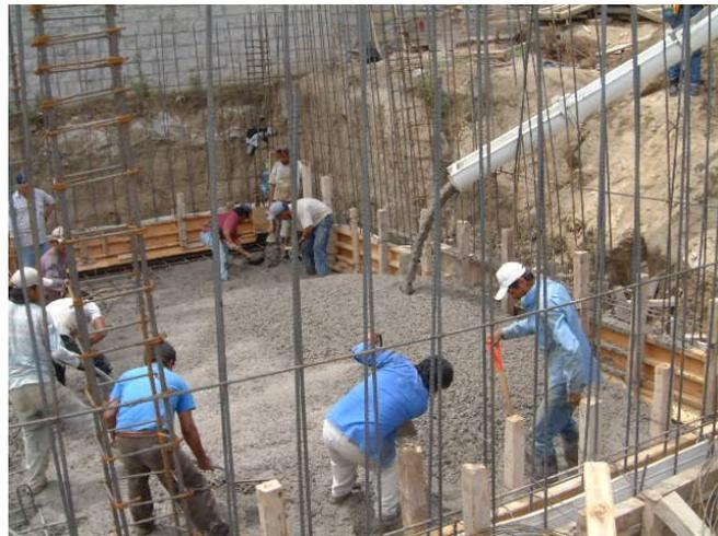
Figura. 3.1.16 Traspaleado del concreto
