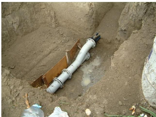
Figura. 3.2.9 Instalación tren de medición
