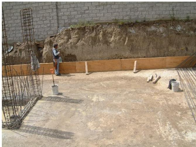
Figura. 3.1.10 Armado losa inferior y cimbra para muro 50 cm.
