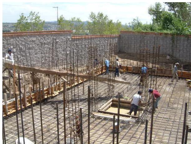
Figura 3.1.14 Instalación de canal para transportar concreto premezclado
