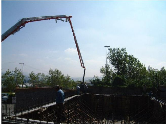
Figura.3.1.25 Colado de muros con bomba y tubo tremi.
