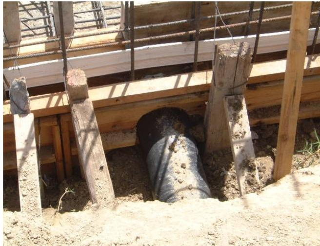
Figura. 3.1.17 Tubería abastecedora y junta PVC.
