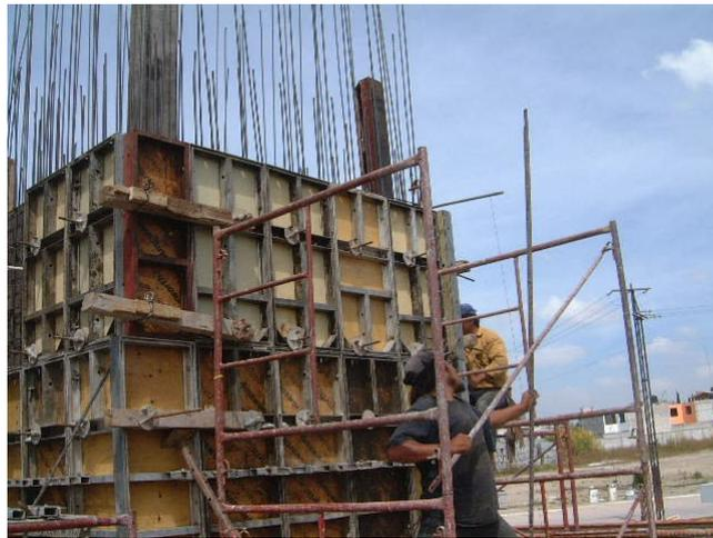
Figura.3.2.1 Cimbrado muro soporte
