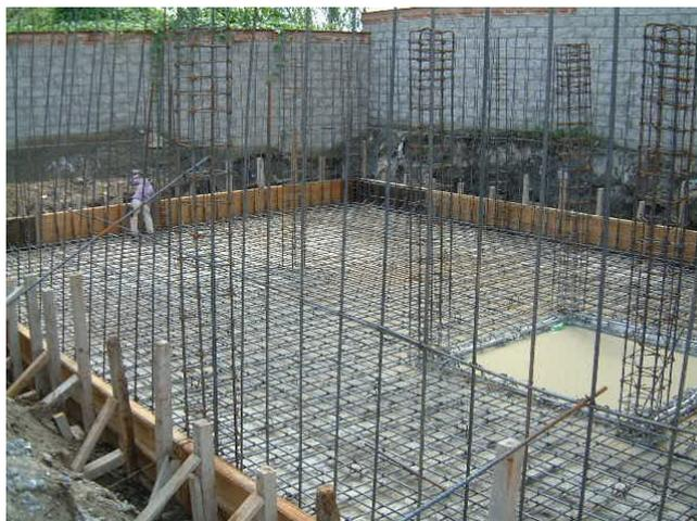
Figura. 3.1.12 Armado de columnas C2
