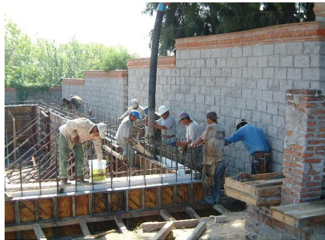
Figura. 3.1.24 Colocación del concreto en muros subsiguientes.
