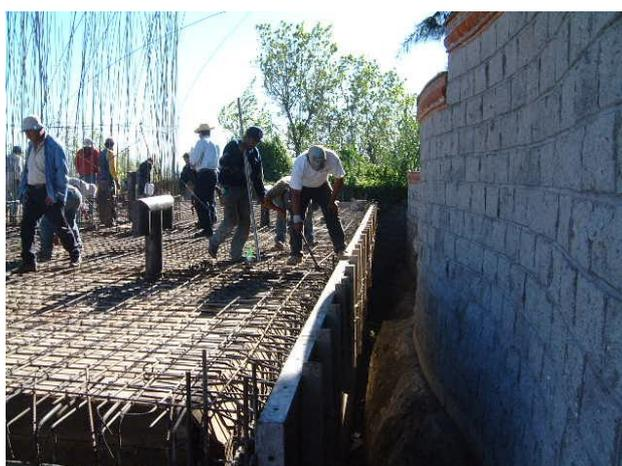
Figura.3.1.29 Armado losa superior
