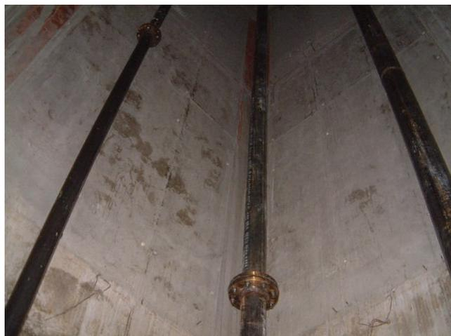
Figura. 3.2.7 Instalación tuberías dentro de muros soporte
