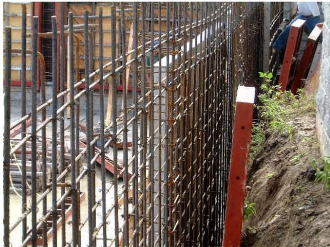
Figura. 3.1.19 Muro doblemente armado
