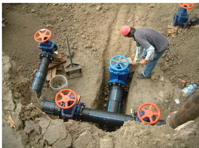
Figura.3.2.10 Relleno en Válvulas
