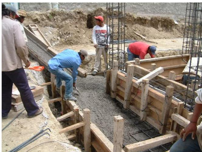
Figura. 3.1.6 Colado y vibrado del concreto premezclado.
