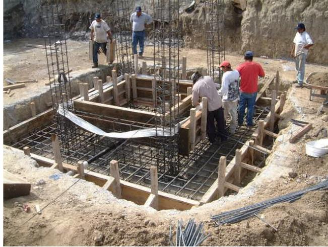
Figura. 3.1.5 Colocación de banda PVC y cimbra en contra trabes
