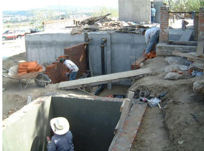
Figura. 3.2.11 Construcción de registros para válvulas
