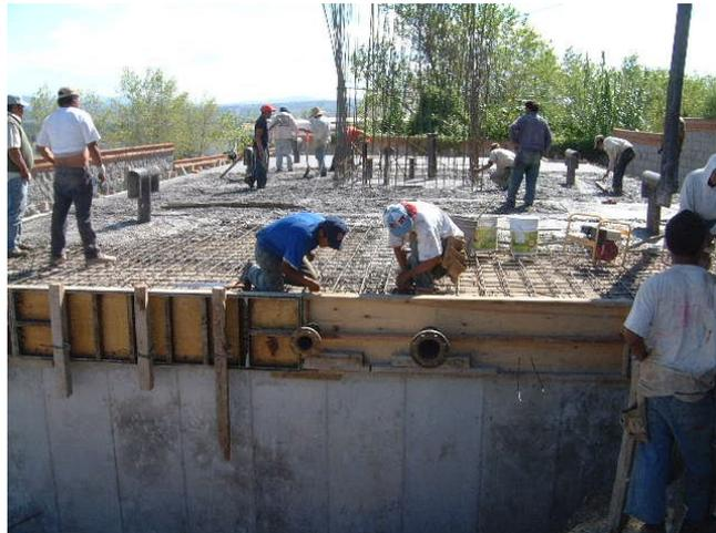
Figura.3.1.32 Colado losa superior
