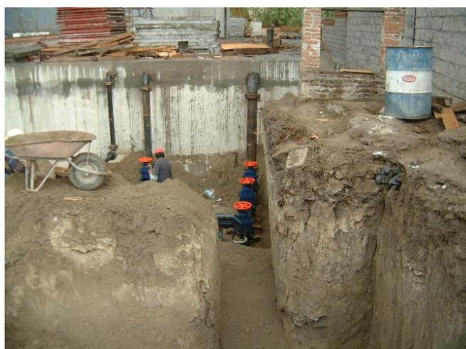
Figura. 3.2.8 Instalación del Tren de válvulas
