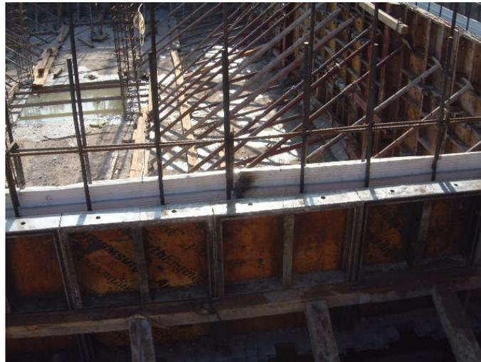
Figura.3.1.22 Banda de PVC termo fusionada.
