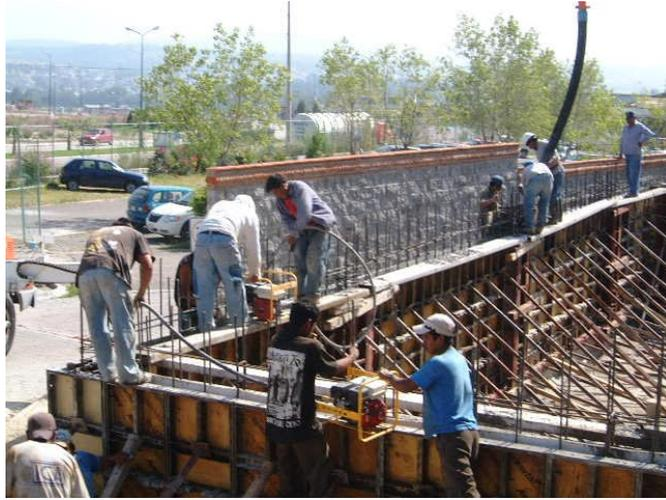
Figura.3.1.23 Colado y vibrado del concreto primer muro.
