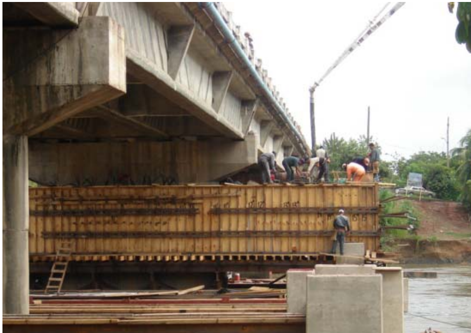
Figura 3.52 Colocación de concreto hidráulico en traveses de transferencia.
