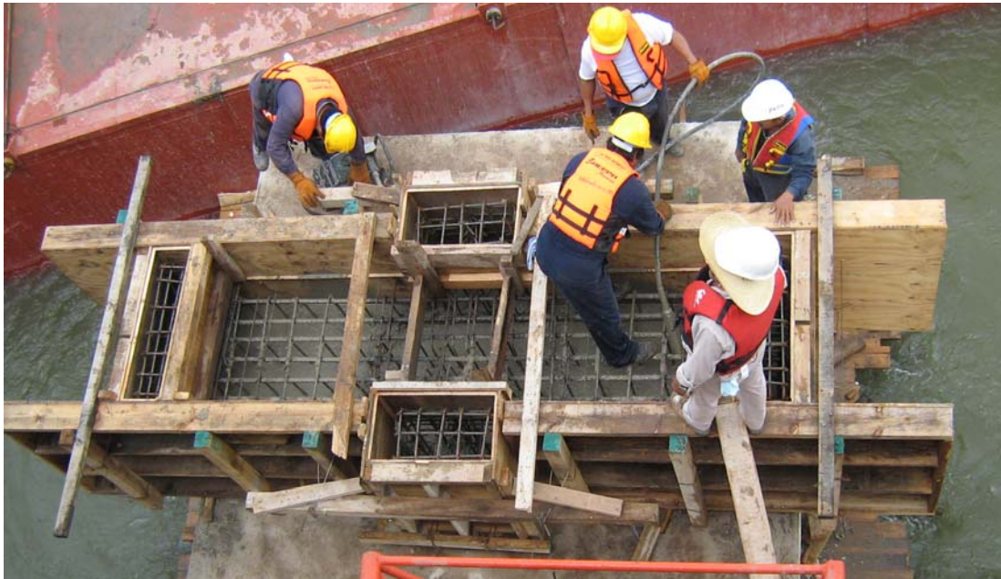
Figura 3.42 Colocación de concreto en cabezales y topes antisísmicos.
