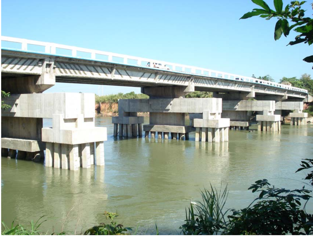
Figura 3.60 Recimentación del puente La Isla.
