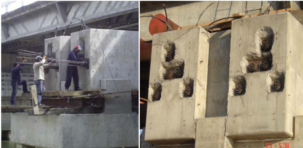
Figura 3.57 Corte de excesos en torones.
