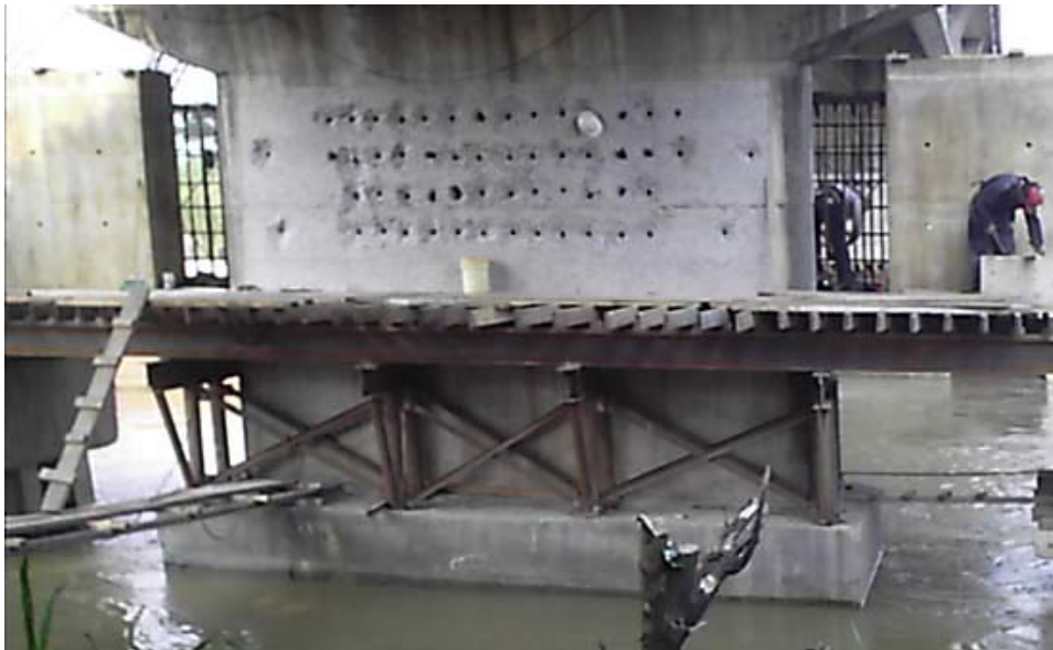
Figura 3.46 Perforación y escarificado de concreto en pilas.
