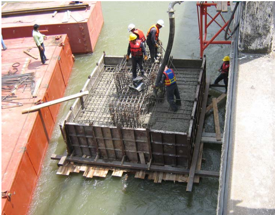
Figura 3.39 Colocación de concreto en zapatas.
