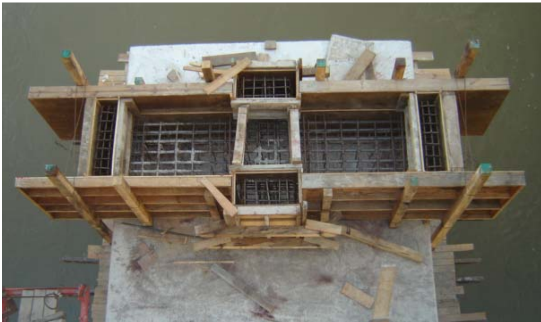
Figura 3.41 Colocación de cimbra en cabezales.
