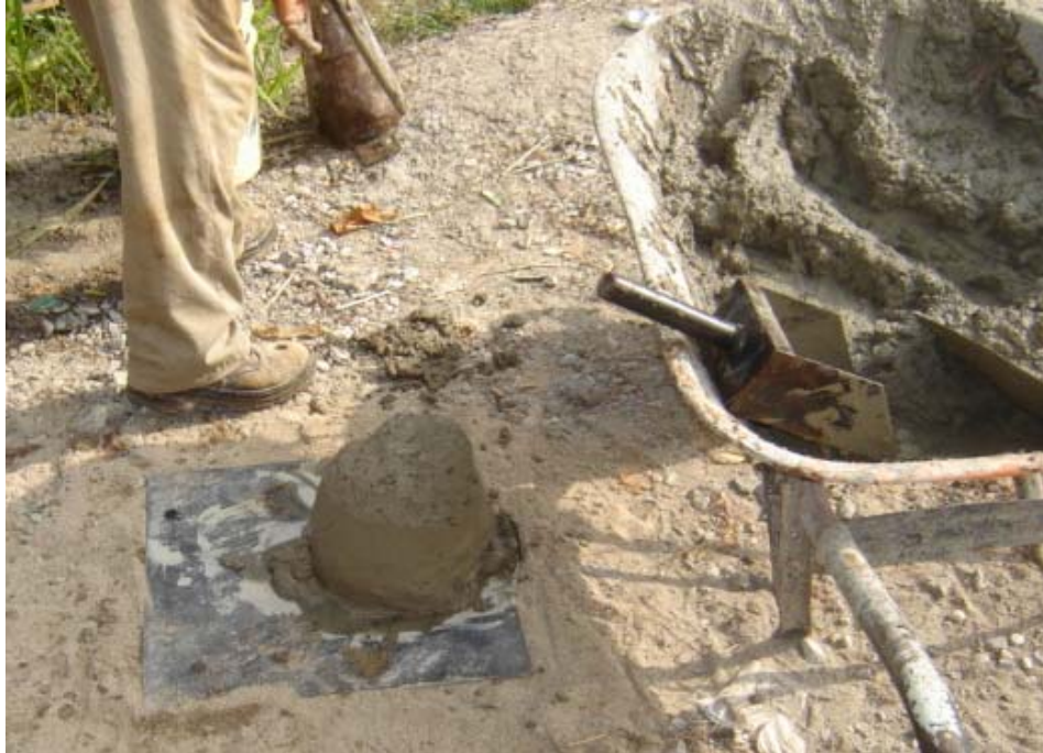
Figura 3.53 prueba de revenimiento.
