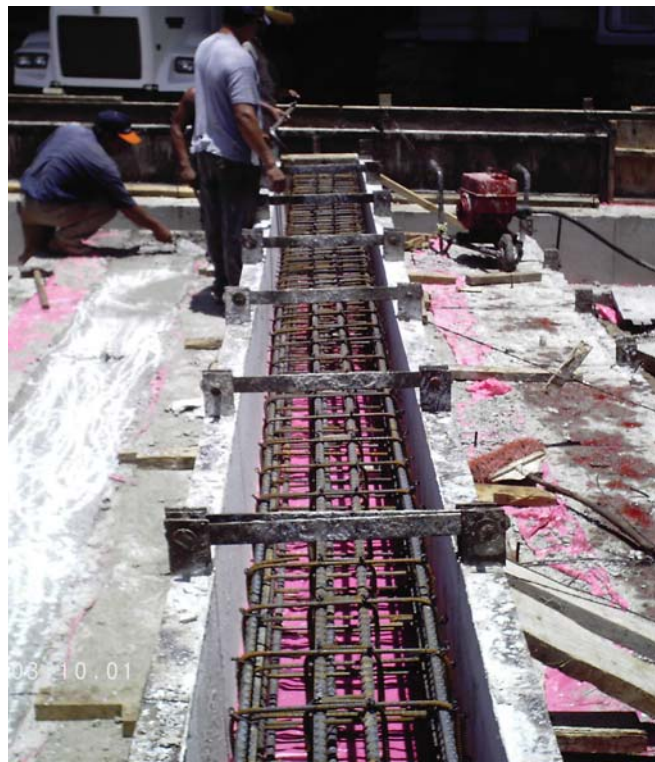
Figura 3.9 Verificación de cimbra.
