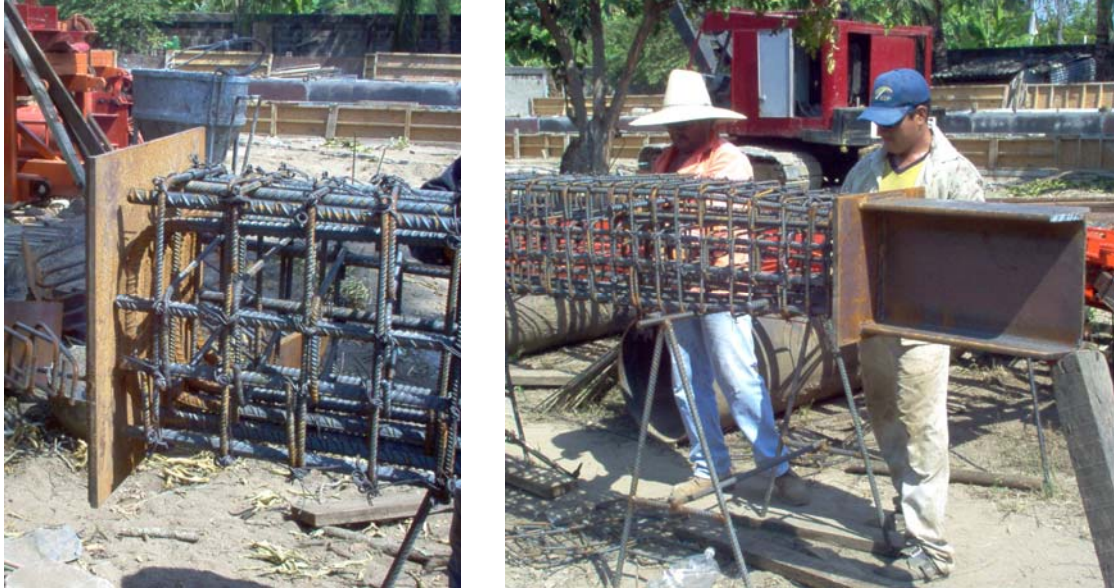
Figura 3.4 Colocación de placas de acero y punta de viga I.
