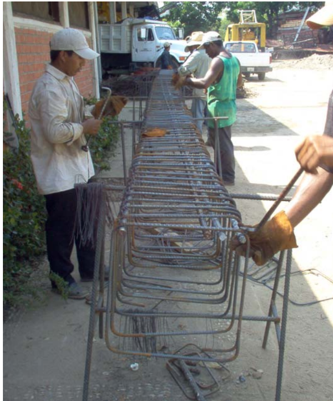
Figura 3.2 Colocación de estribos.
