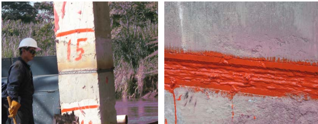
Figura 3.26 Detalle de soldadura y aplicación de impermeabilizante.
