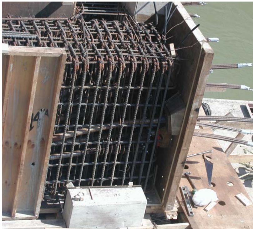
Figura 3.48 Cajas de anclas y zunchos.
