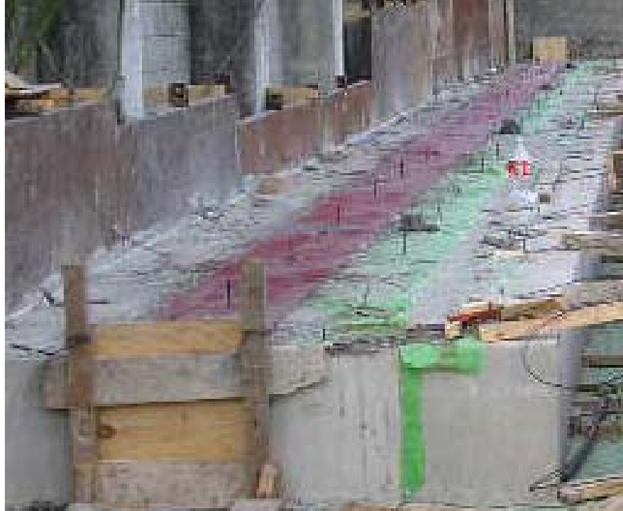
Figura 3.16 Curado del pilote.
