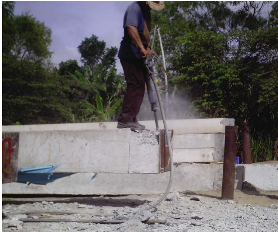
Figura 3.27 Demolición de concreto en pilotes.
