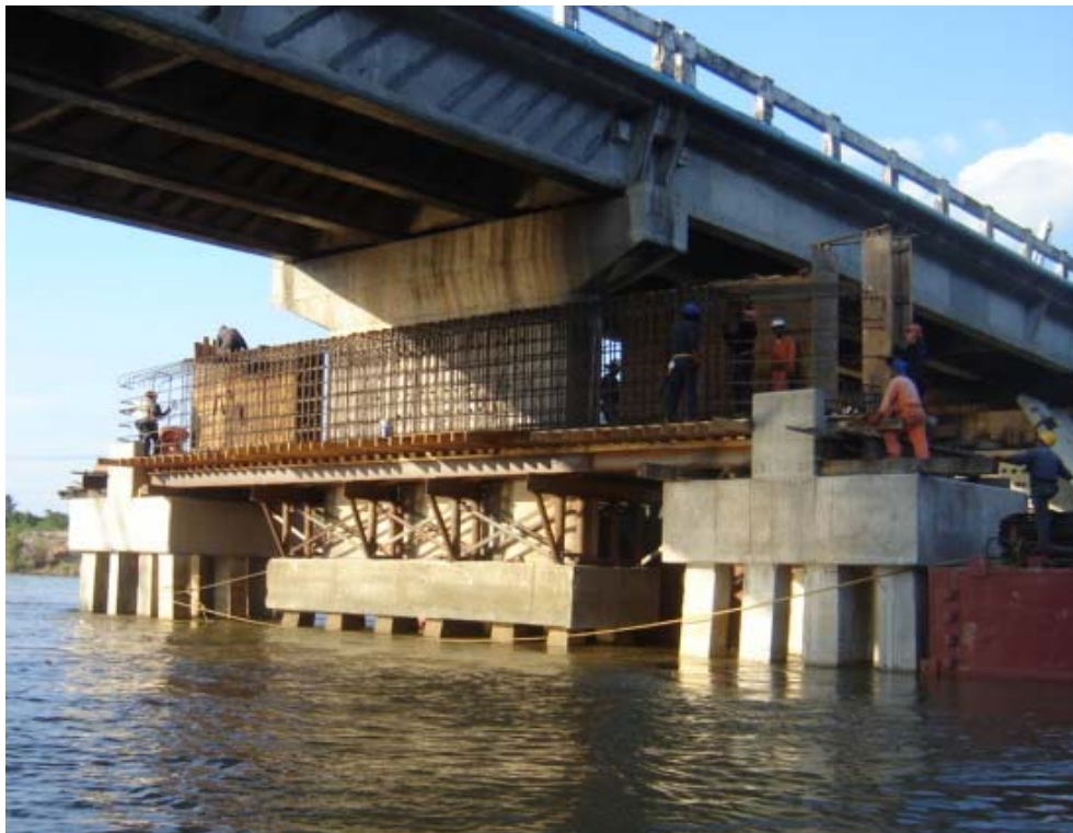
Figura 3.47 Colocación de acero de refuerzo en trabes.
