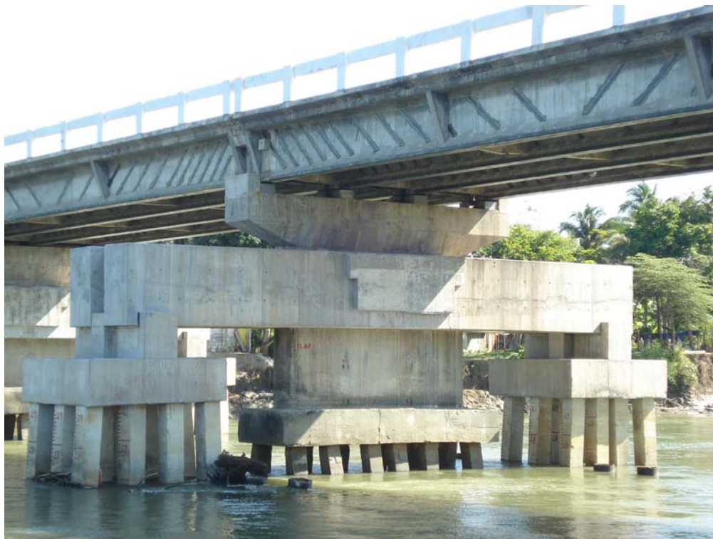
Figura 3.59 Traveses de Transferencia.
