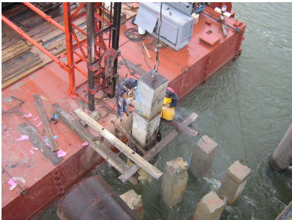
Figura 3.33 Colocación de tramo de 1.20 m. de longitud.
