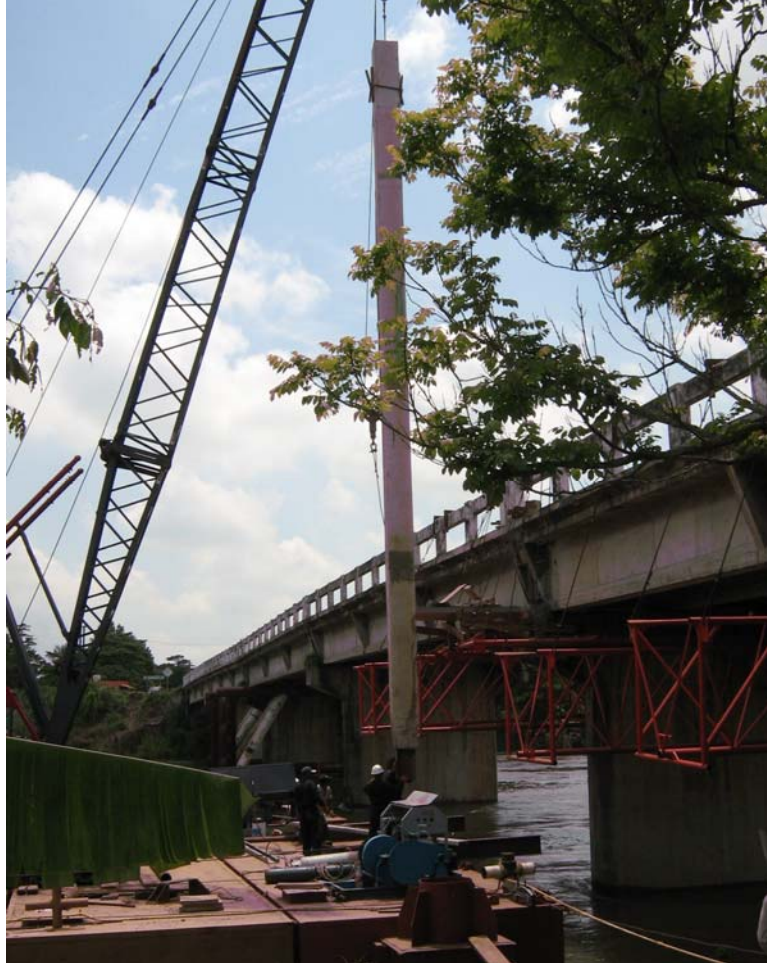
Figura 3.23 Colocación de la 1ra sección de pilote.
