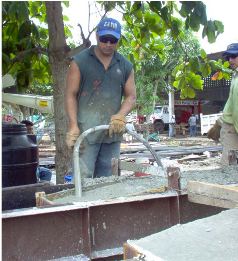
Figura 3.14 Vibrado de concreto.
