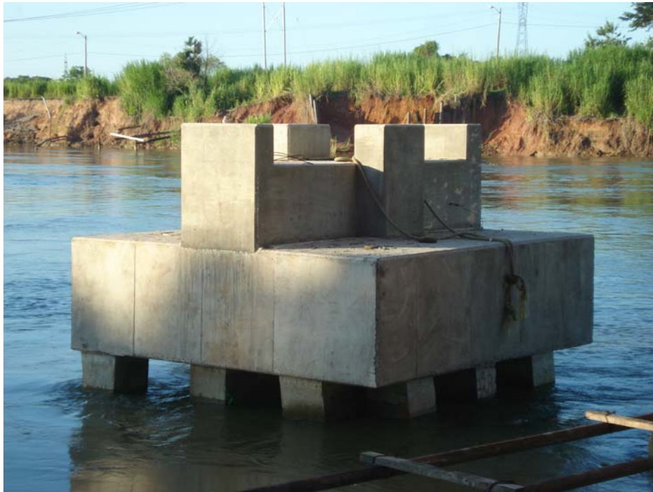
Figura 3.44 Zapatas-cabezal de concreto reforzado.
