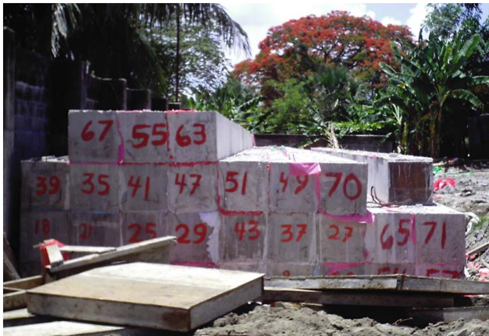
Figura 3.17 Almacenamiento de pilotes.
