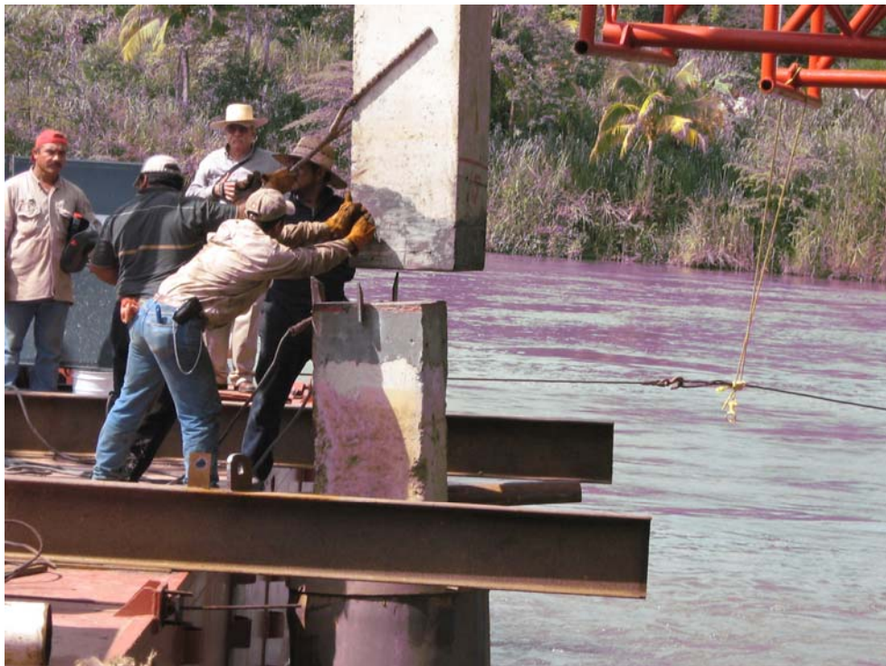
Figura 3.24 Colocación de la 2da sección de pilote.
