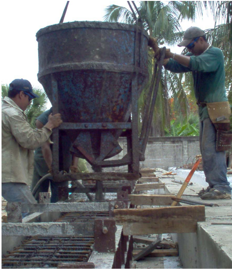
Figura 3.13 Colocación de concreto.
