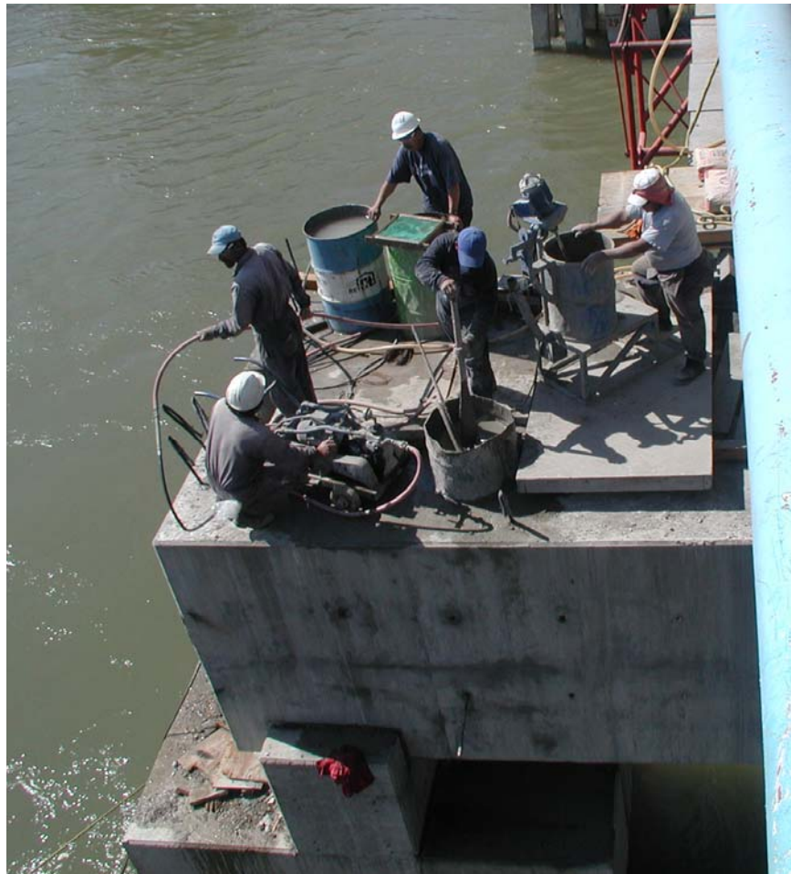
Figura 3.56 Inyección de mortero a conductos.
