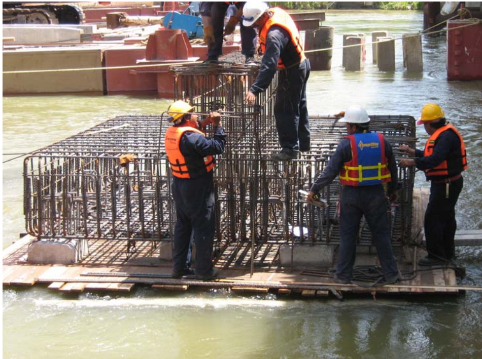
Figura 3.36 Habilitado y colocación de acero de refuerzo en zapatas-cabezal.
