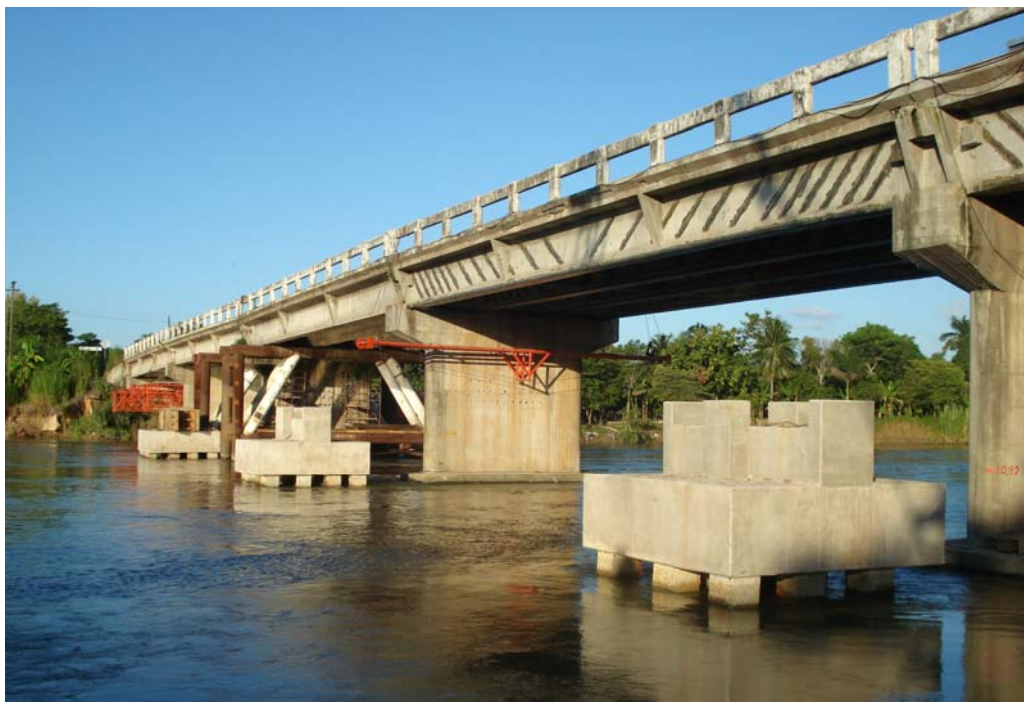
Figura 3.45 Construcción de Zapatas-cabezales de concreto reforzado.
