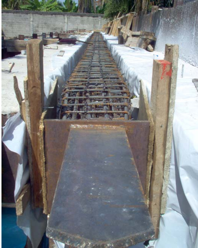
Figura 3.8 Cimbrado de pilotes de concreto reforzado.
