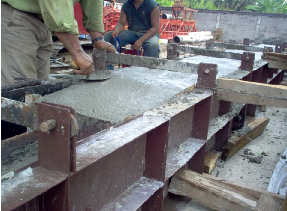
Figura 3.15 Acabado superficial del pilote.
