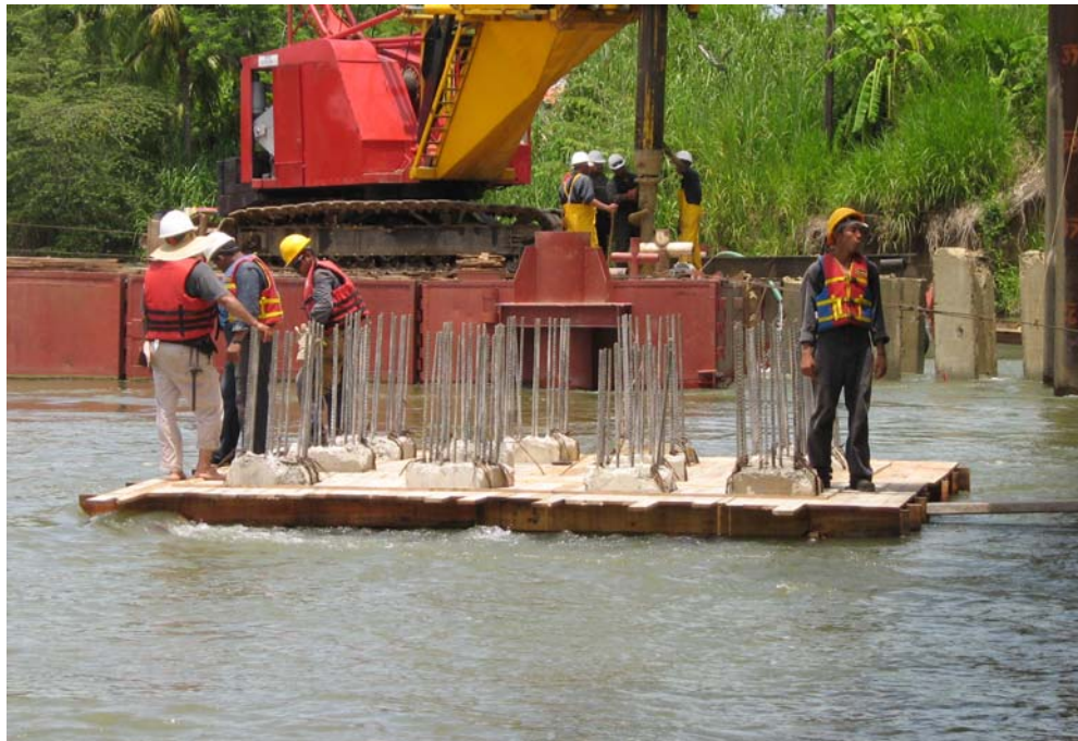
Figura 3.35 Descabece de pilotes de concreto reforzado.
