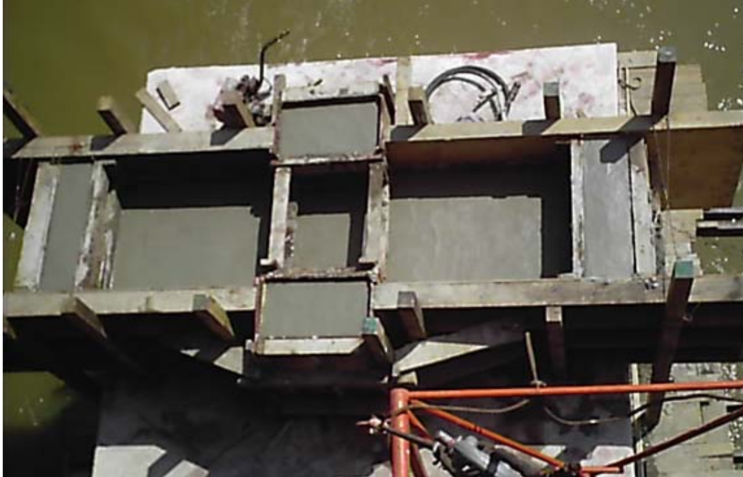
Figura 3.43 Acabado de cabezales y topes antisísmicos.
