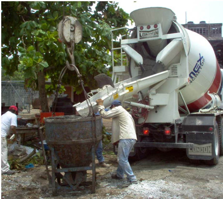
Figura 3.12 Suministro de concreto en bote.
