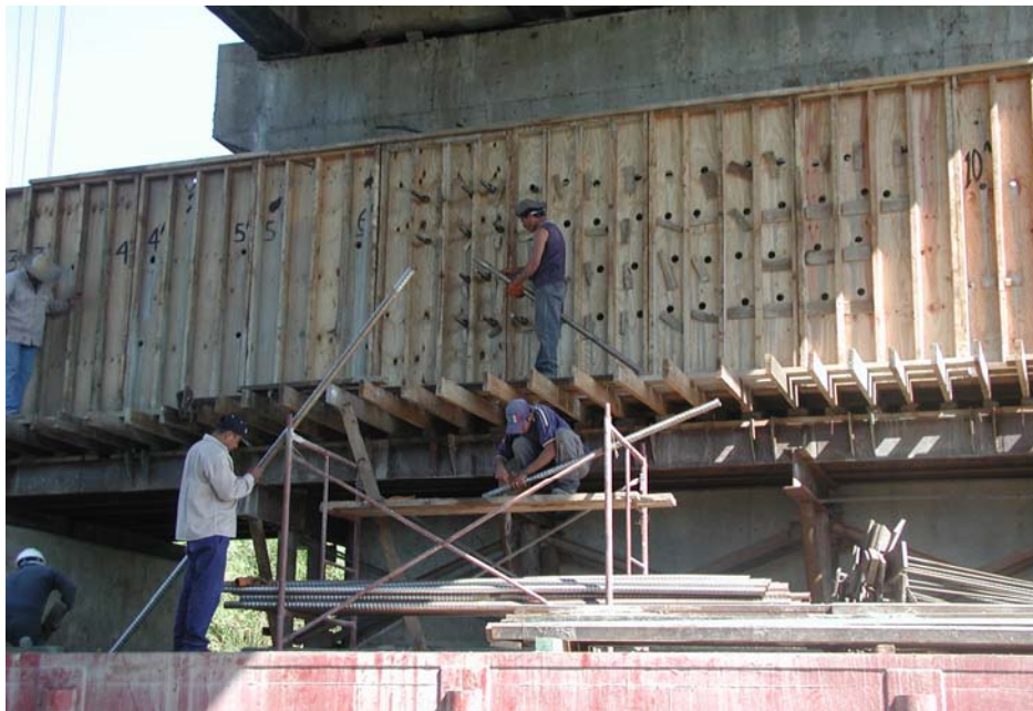
Figura 3.51 Colocación de barras de presfuerzo tipo Mackalloy.
