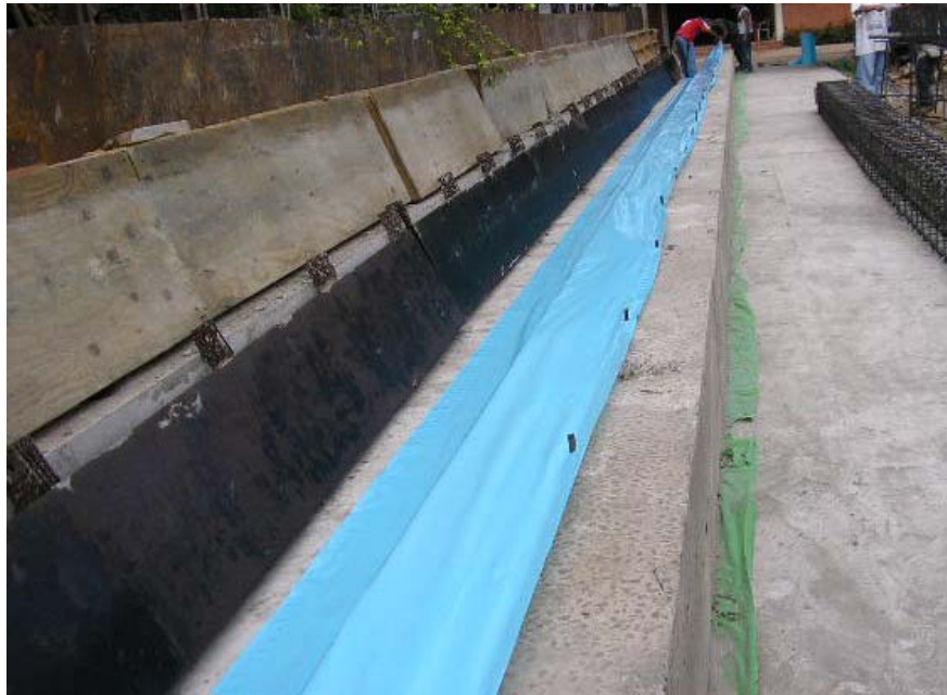
Figura 3.5 Colocación de cimbra para el colado de pilotes.
