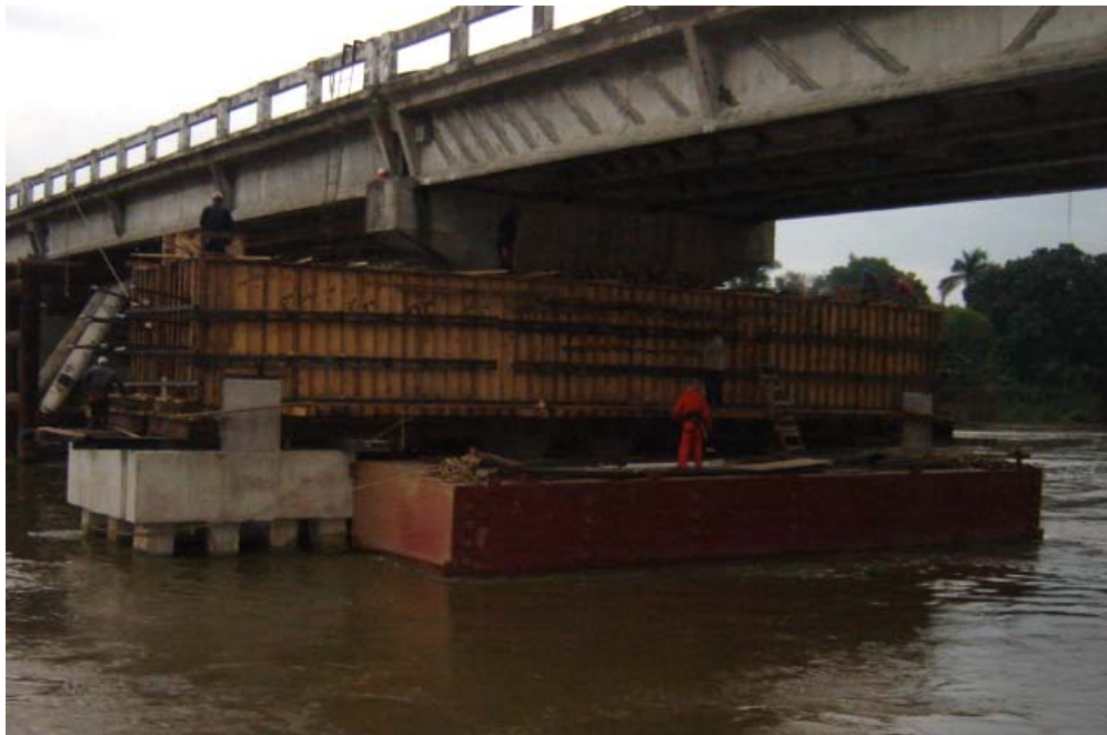
Figura 3.49 Colocación de cimbra en trabes de transferencia.
