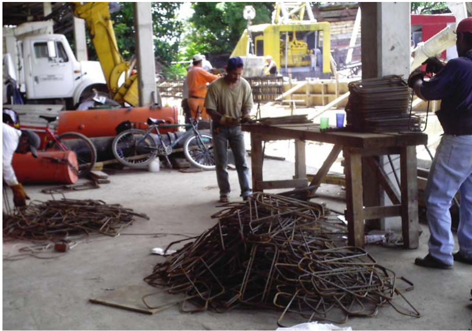
Figura 3.1 Habilidadado de acero de refuerzo.
