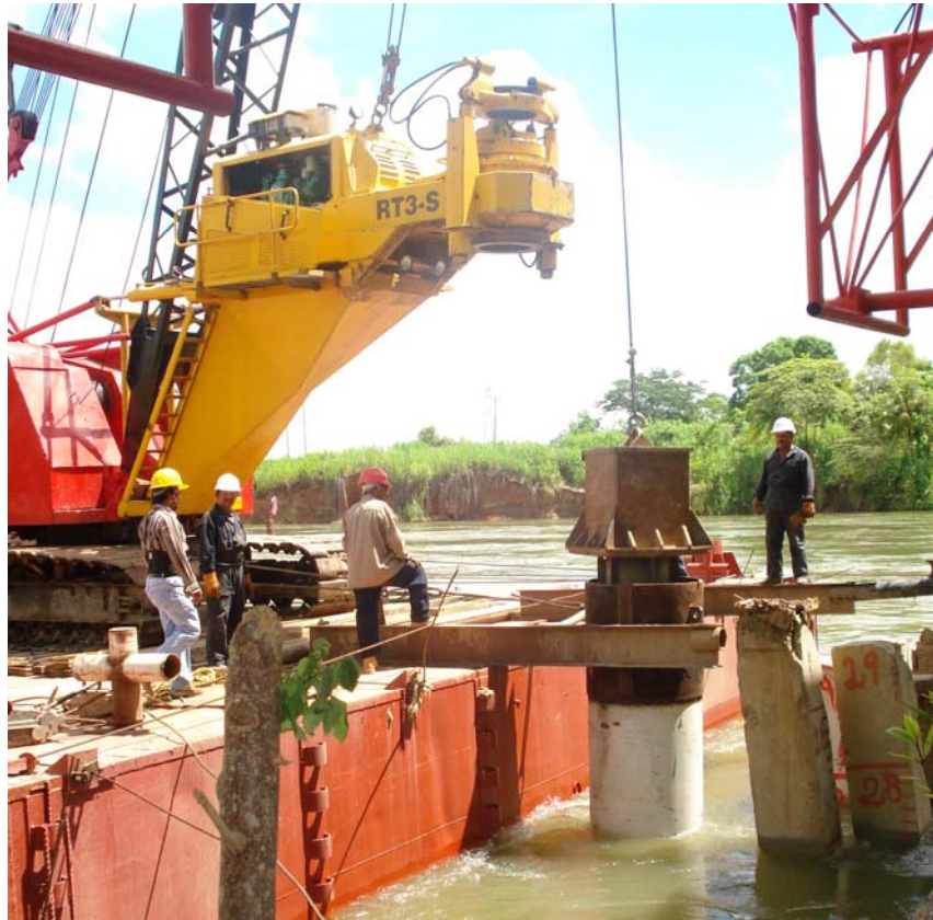
Figura 3.21 Colocación de camisa metálica.
