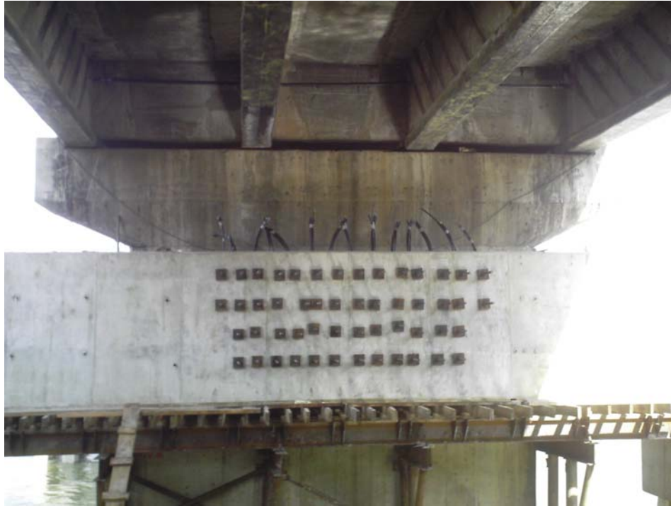
Figura 3.54 Postensado de barras Mackalloy.
