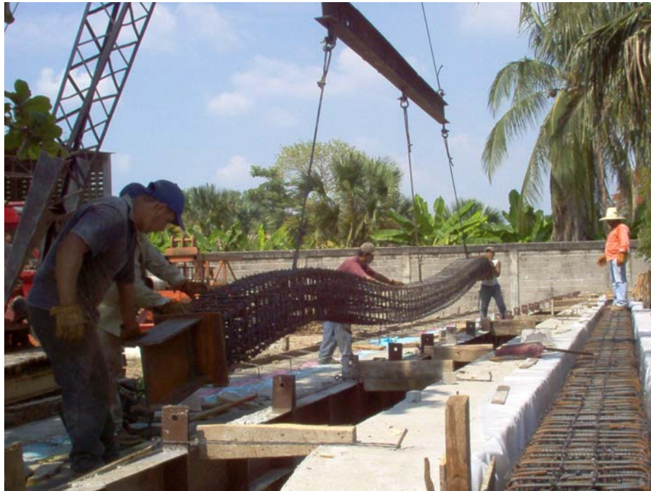
Figura 3.6 Izamiento de tramos.
