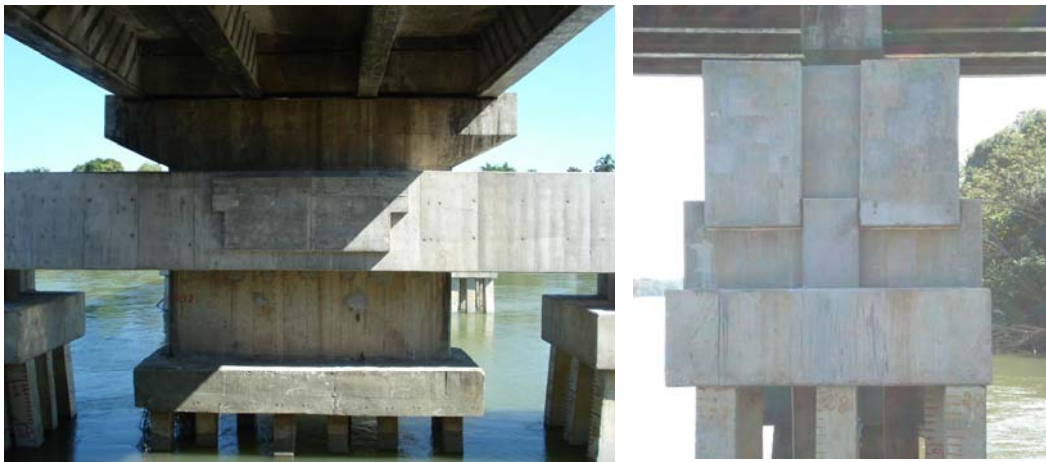
Figura 3.58 Colocación de concreto en anclas.
