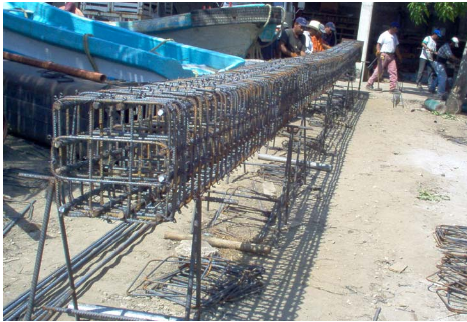
Figura 3.3 Colocación de acero de refuerzo.
