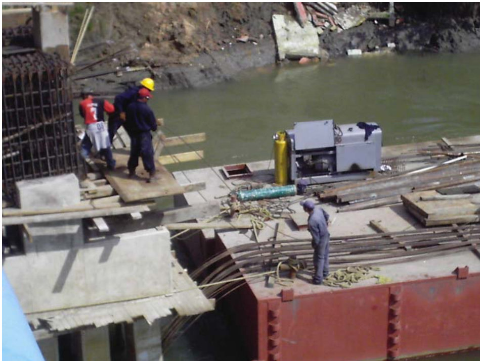
Figura 3.50 Colocación de cables de presfuerzo longitudinal.
