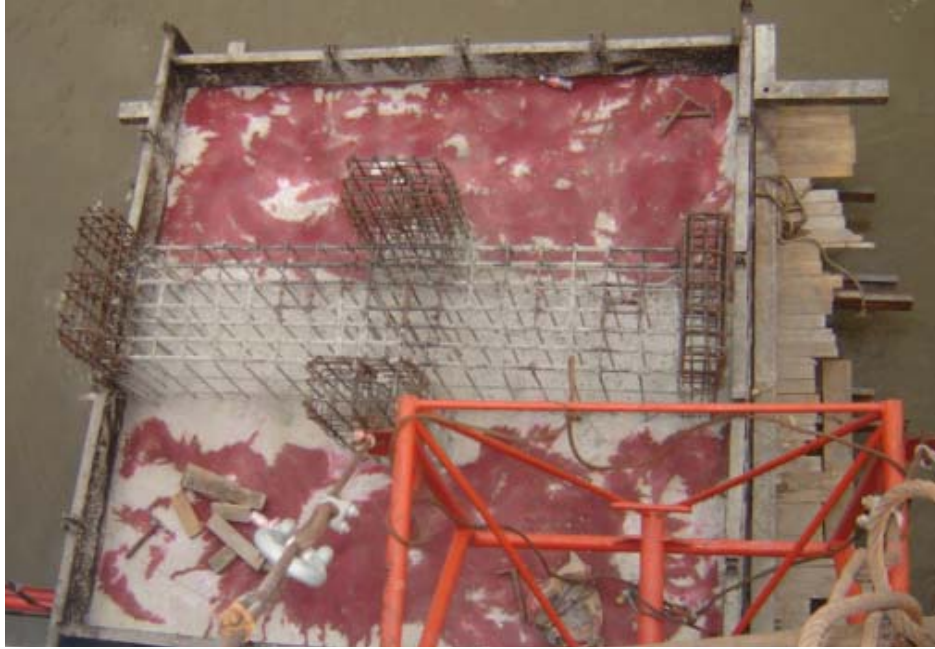
Figura 3.40 Colocación de concreto en zapatas.
