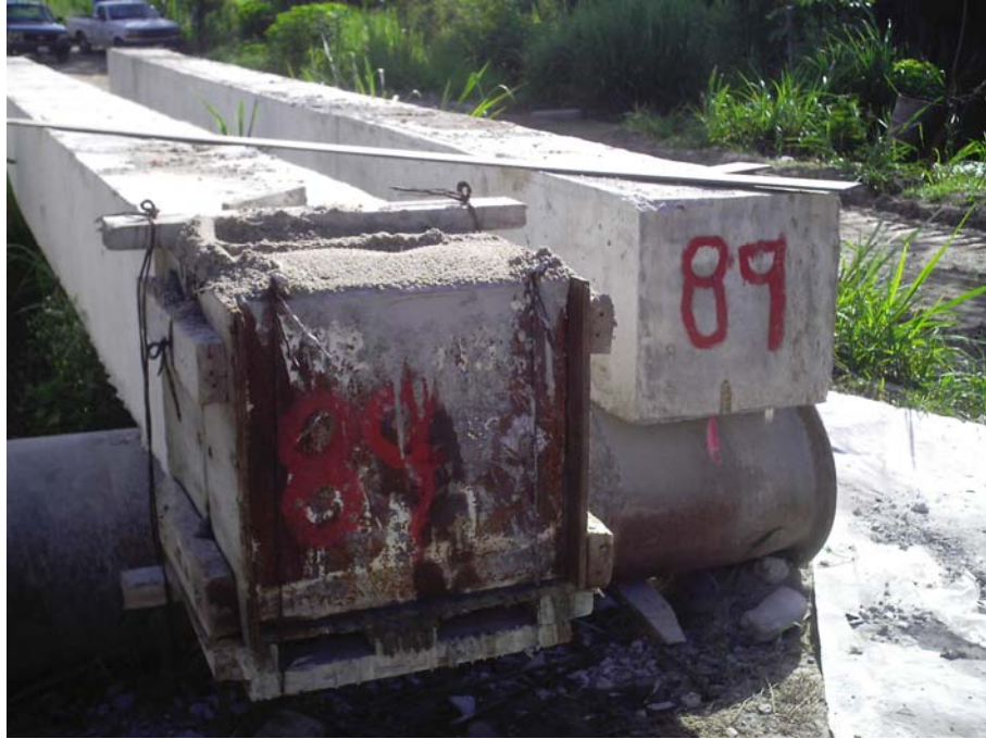
Figura 3.29 Suministro de concreto hidráulico.
