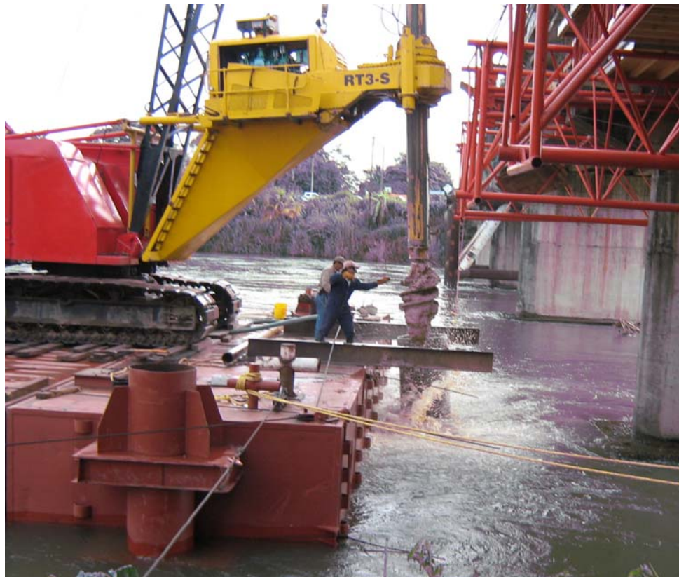
Figura 3.22 Perforación previa al hincado.
