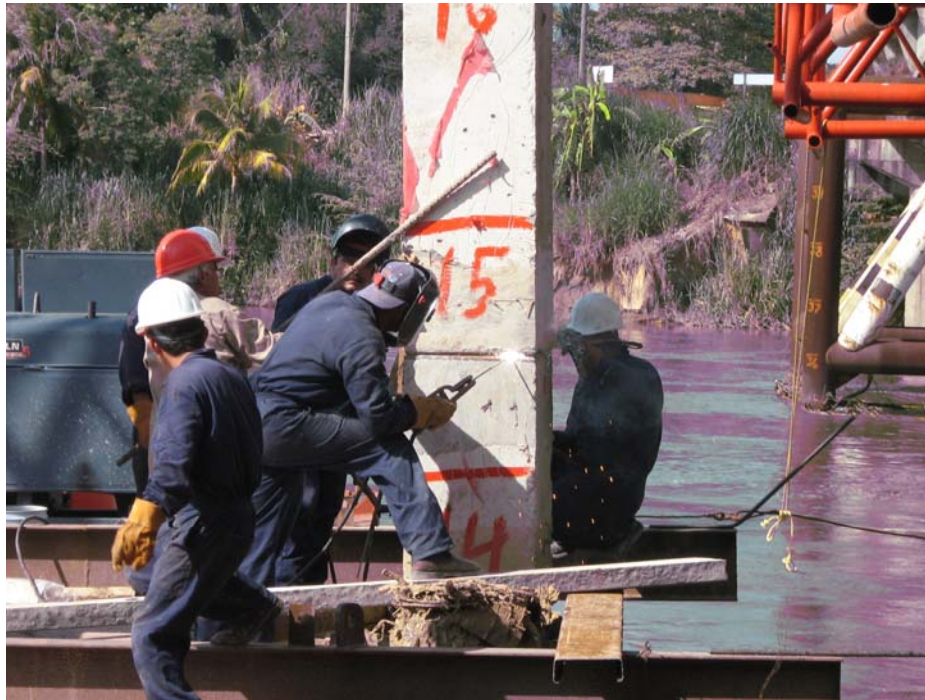
Figura 3.25 Unión de los tramos de pilote.
