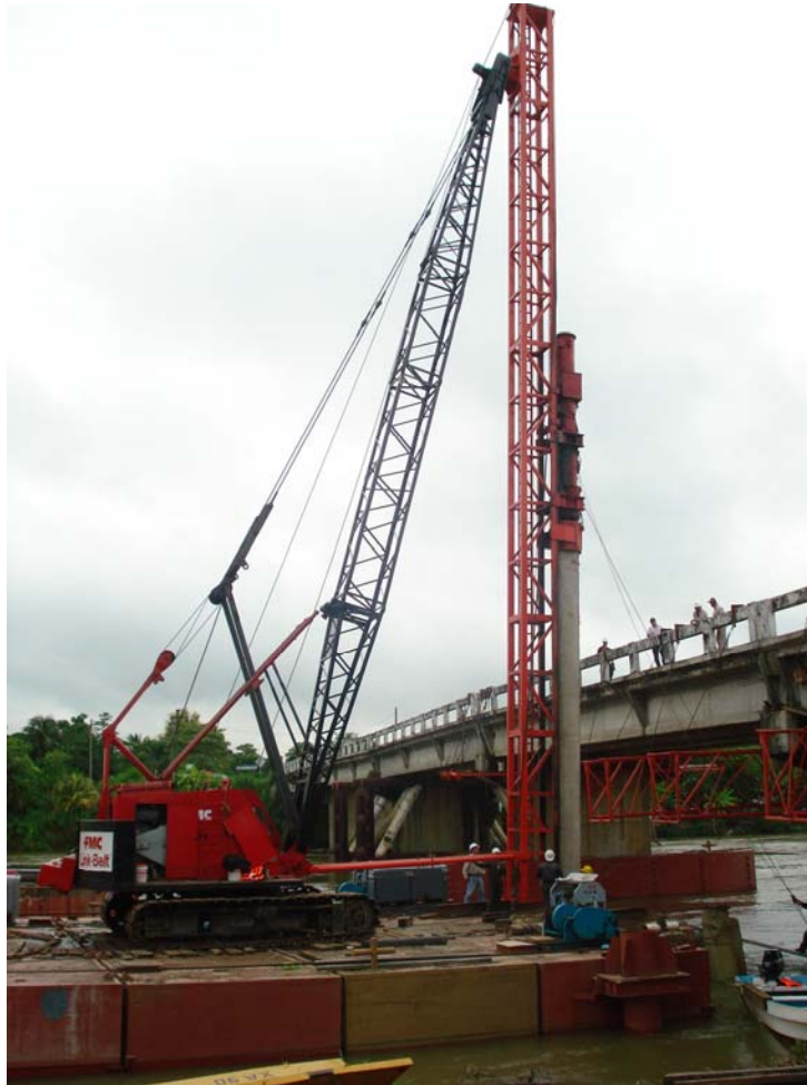
Figura 3.30 Hincado de pilotes de concreto reforzado.
