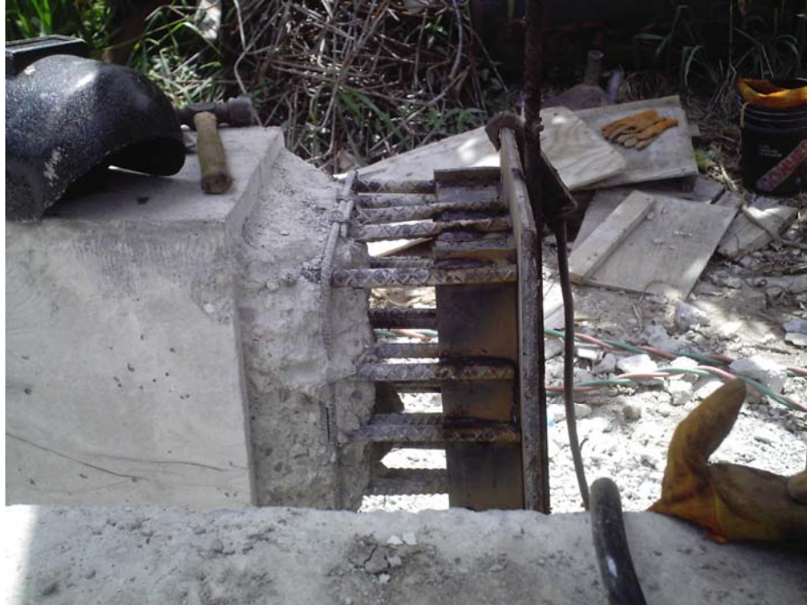
Figura 3.28 Colocación de soleras de acero.
