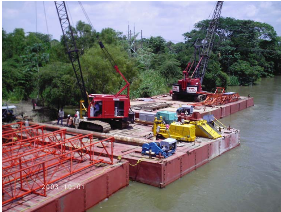
Figura 3.18 Armado de Chalanes.
