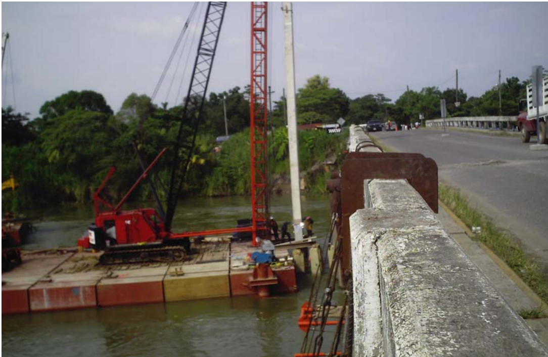
Figura 3.34 Colocación de tramo cabeza.
