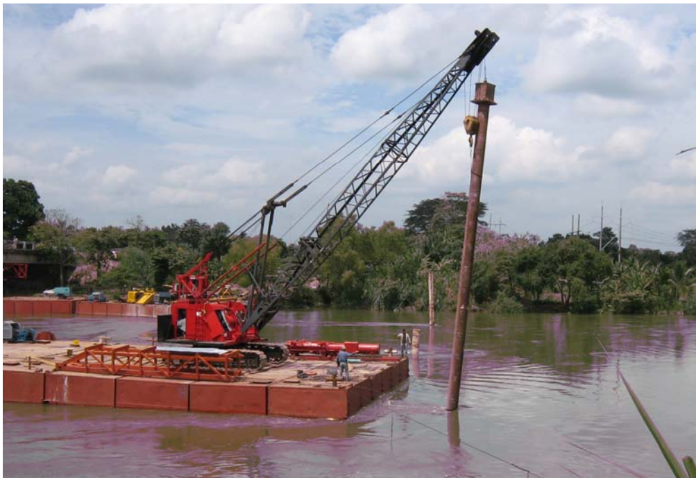
Figura 3.19 Hincado de pilotes de apoyo.
