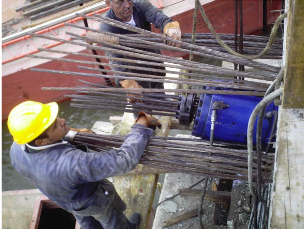
Figura 3.55 Postensado longitudinal de traves de transferencia.
