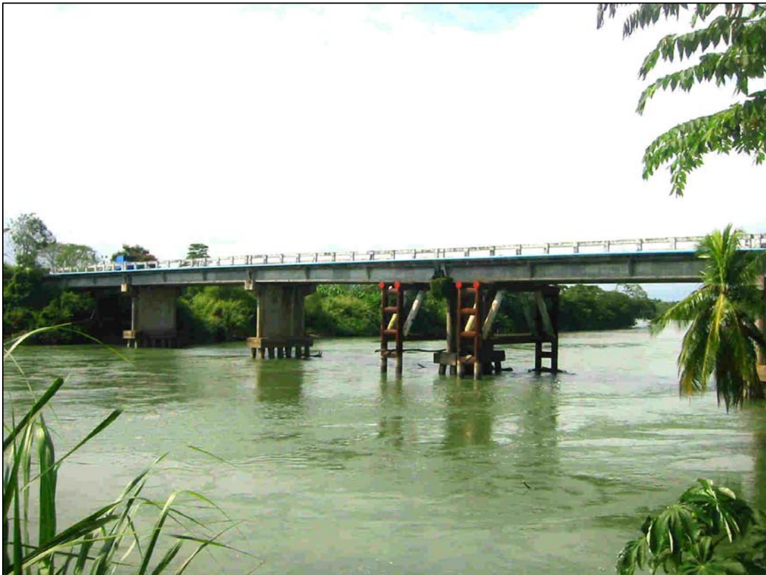
Figura 1.1 Puente La Isla.
