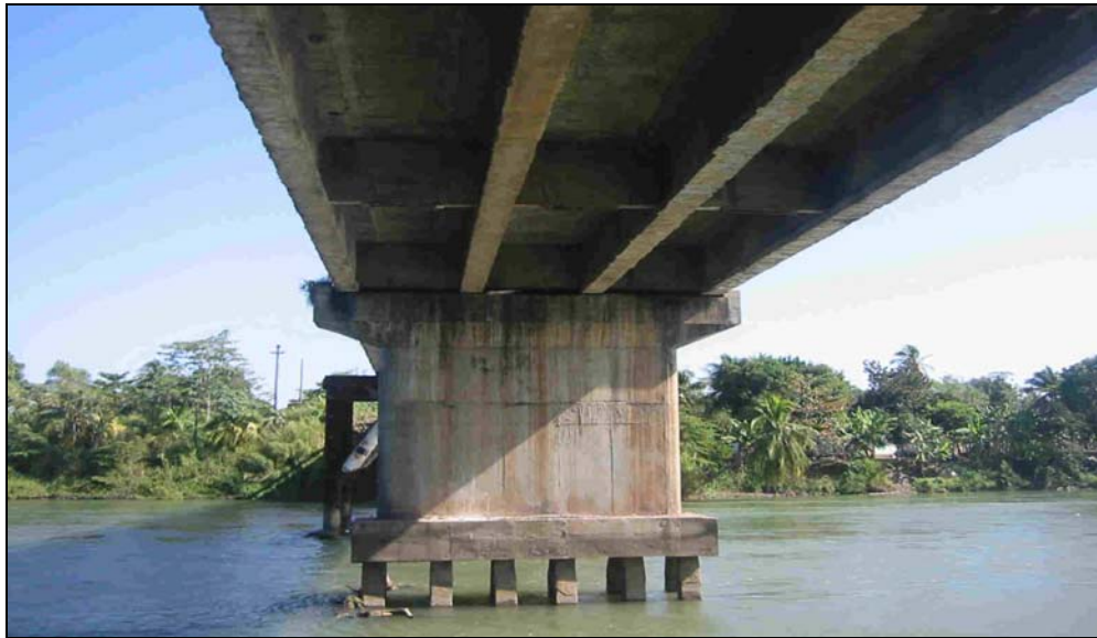
Figura 1.3 Superestructura (Trabes y Diafragmas).
