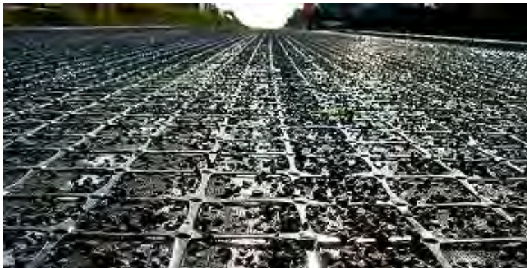
Figura 18.- Geomalla colocada en campo (Geosintéticos Origo, 2021).
