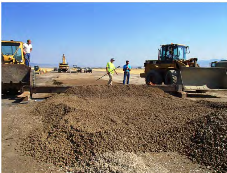
Figura 44.- Nivelación de la grava en la superficie (Cuelho E., Perkins S. & Morris Z., 2014).
