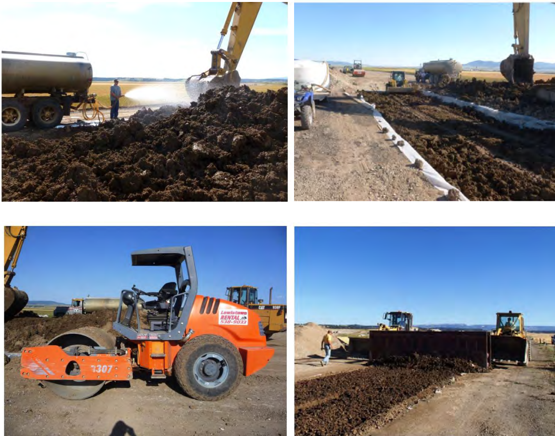
Figuras 36-39.- Esquina superior izquierda: Humedecimiento y mezclado de la subrasante con la excavadora; Esquina superior derecha: Seguimiento en la colocación de la subrasante con minicargador montado sobre orugas; Esquina inferior izquierda: Compactador liso empleado en compactación de la subrasante; Esquina inferior derecha: Nivelación final de la capa de subrasante. (Cuelho E., Perkins S. & Morris Z., 2014).
