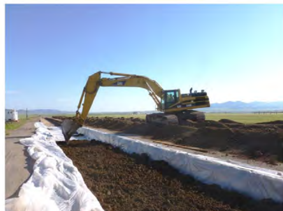
Figuras 34 y 35.- Reporte fotográfico de la construcción del tramo de prueba, a la izquierda la excavación terminada y a la derecha la colocación de la subrasante en la excavación (Cuelho E., Perkins S. & Morris Z., 2014).
