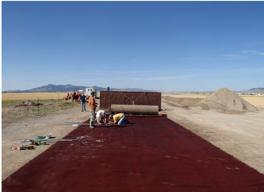
Figura 43.- Instalación del geosintético (Cuelho E., Perkins S. & Morris Z., 2014).
