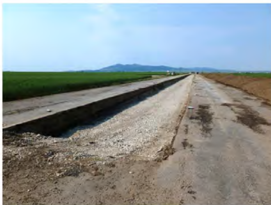
Figuras 34 y 35.- Reporte fotográfico de la construcción del tramo de prueba, a la izquierda la excavación terminada y a la derecha la colocación de la subrasante en la excavación (Cuelho E., Perkins S. & Morris Z., 2014).
