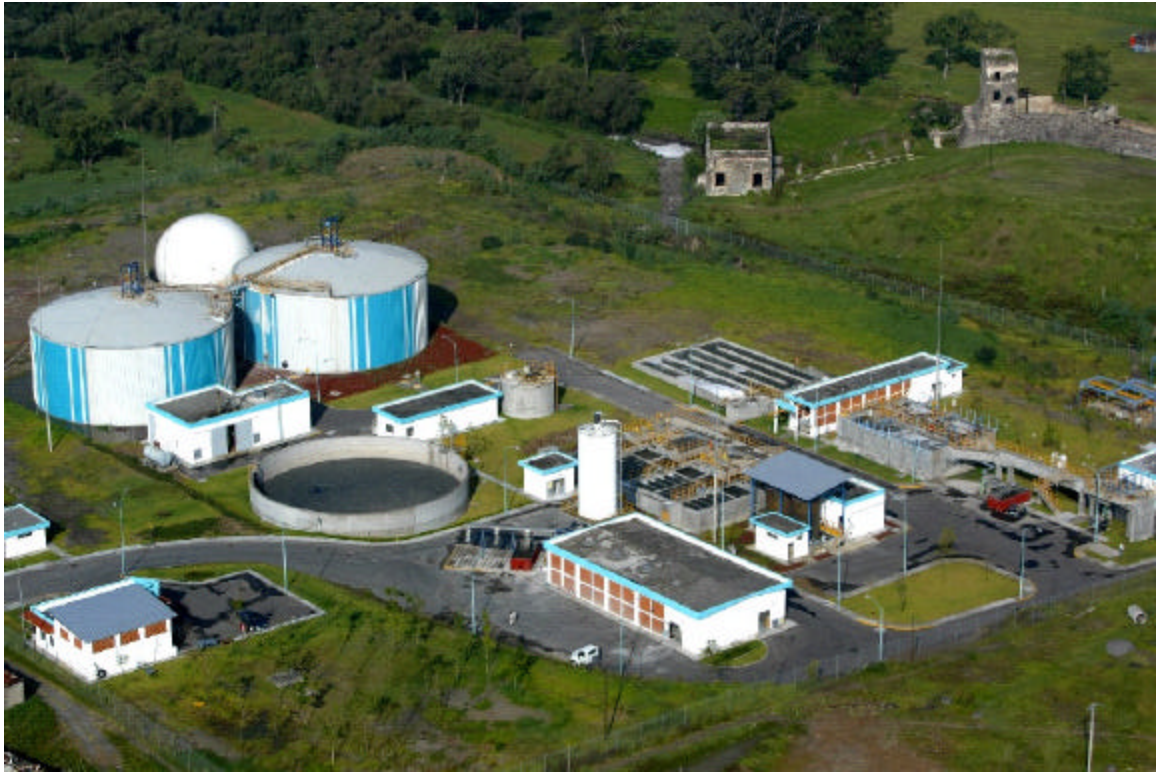
Figura 1.2 Foto aérea de la Planta de tratamiento Atoyac Sur. (SOAPAP)
