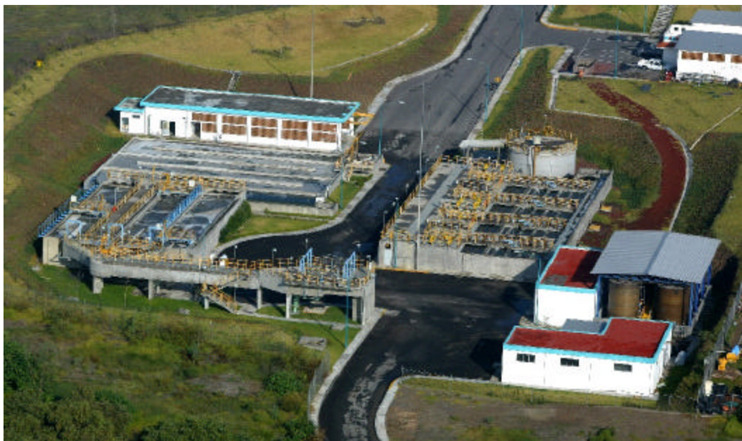
Figura 1.3 Foto aérea de la Planta de tratamiento San Francisco. (SOAPAP)
