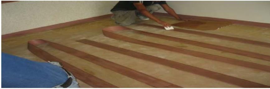
**Imagen 1.4:** *Preparación del zoclo con pegamento para su instalación.*
