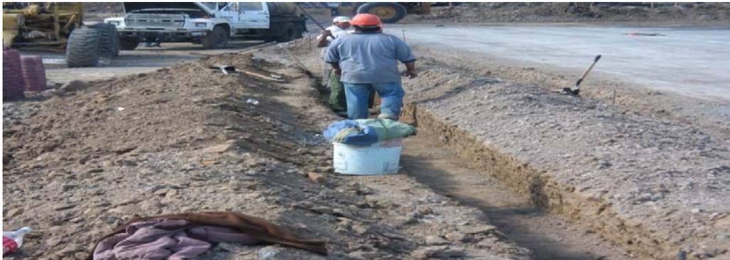
**Imagen 1.9 :** Preparación de terreno para instalación de drenaje
