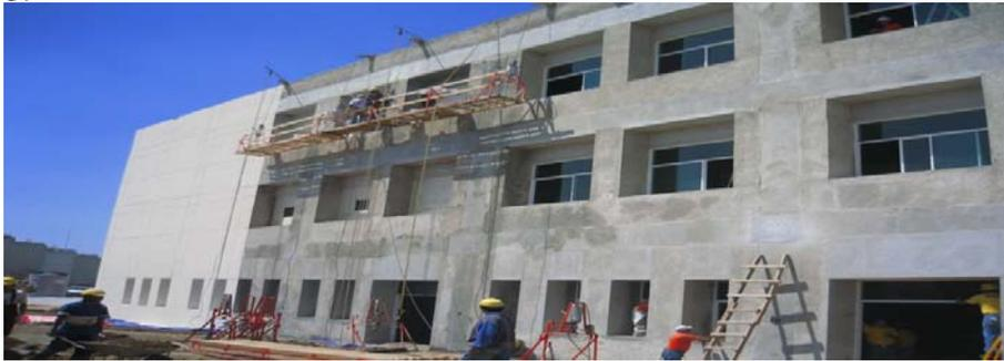
**Imagen 1.1:** *repellado/lechereado de la fachada principal del hospital.*
