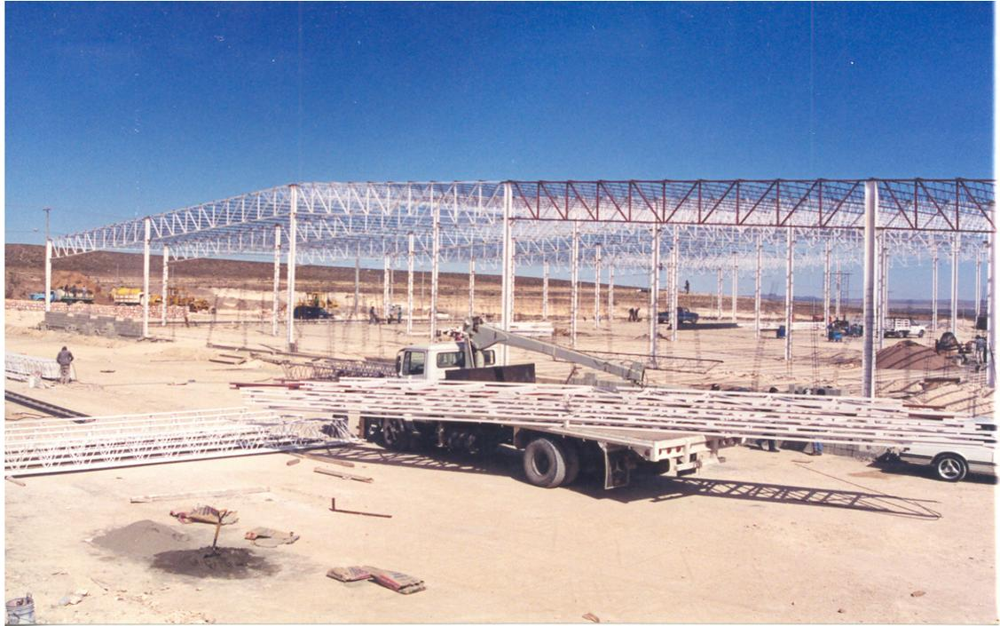
**Fig. 5.4 MONTAJE DE TRABES**
