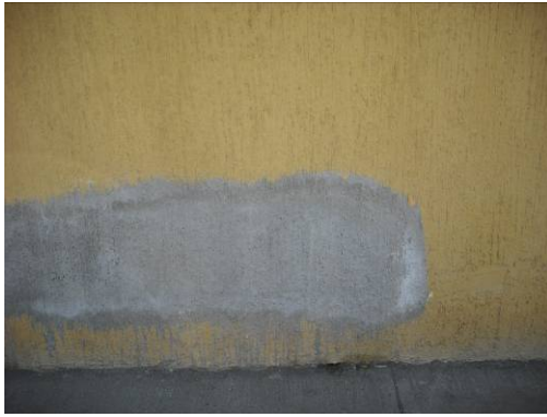
Figura 5.3.1. Detalle de muro en reparación.
