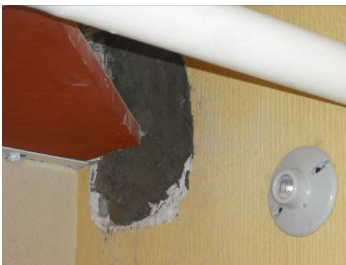
Figura 5.1.3 Vista de la reparación de muro bajo escalera.
