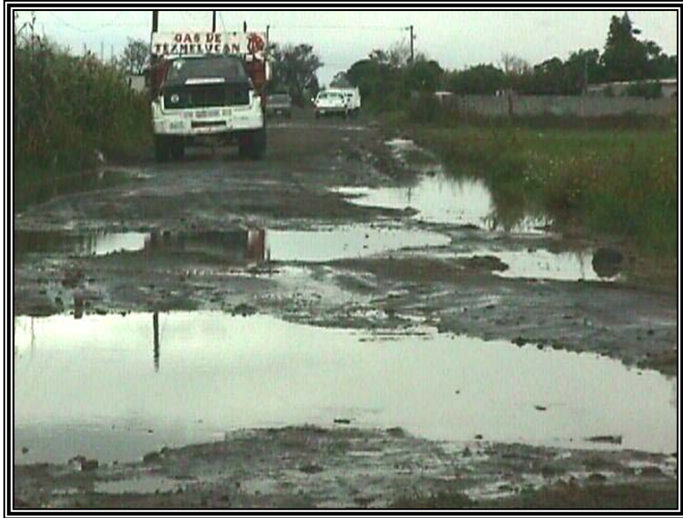
Figura 10. Zona del Km. 2+600 y estado actual.
