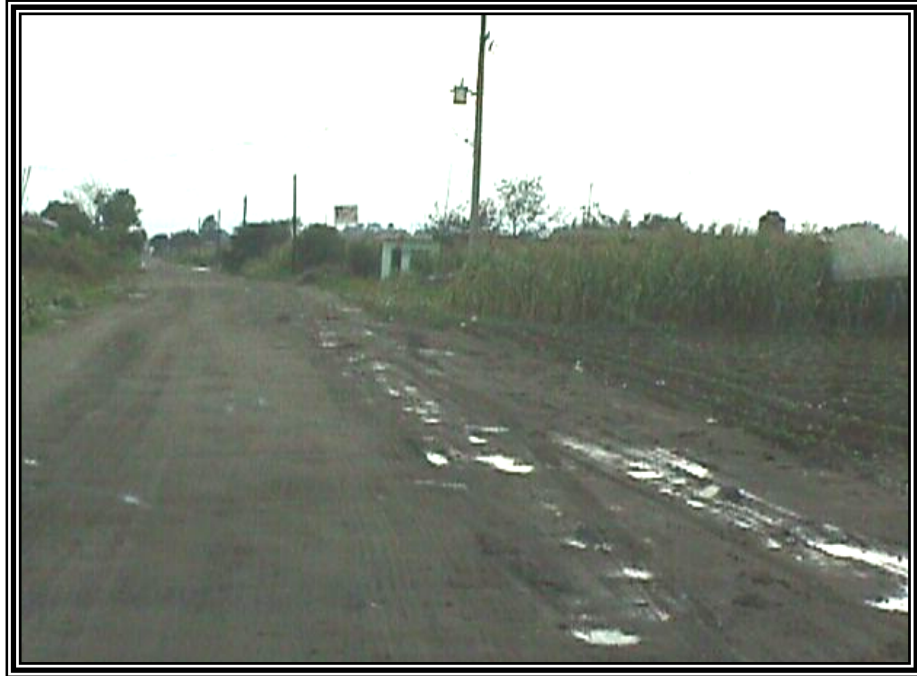
Figura 8. Zona del Km. 0+500 y estado actual.
