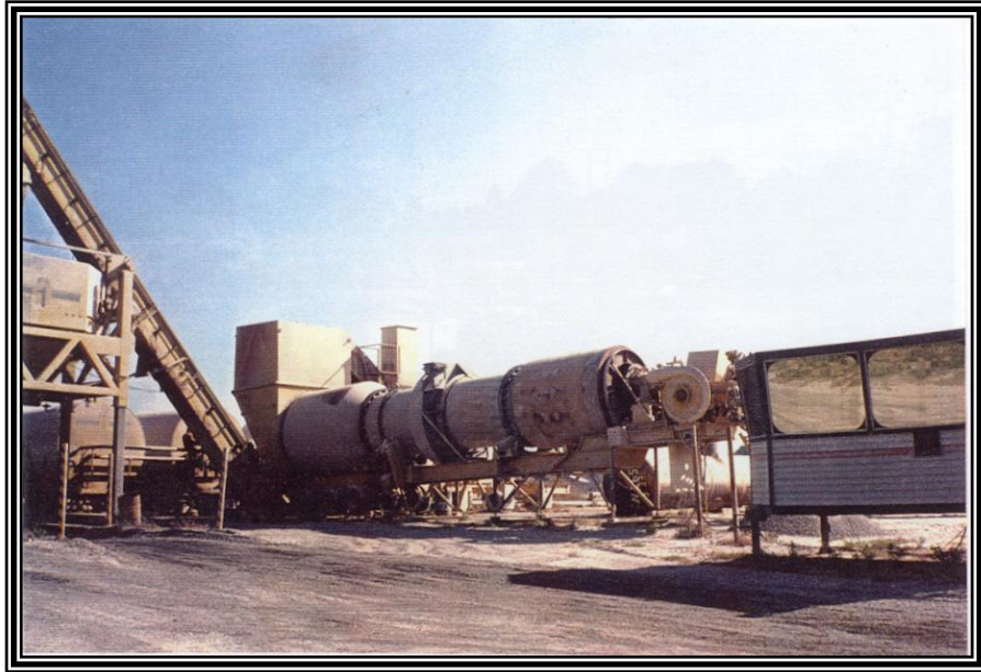
Figura 16. Planta de Asfalto
