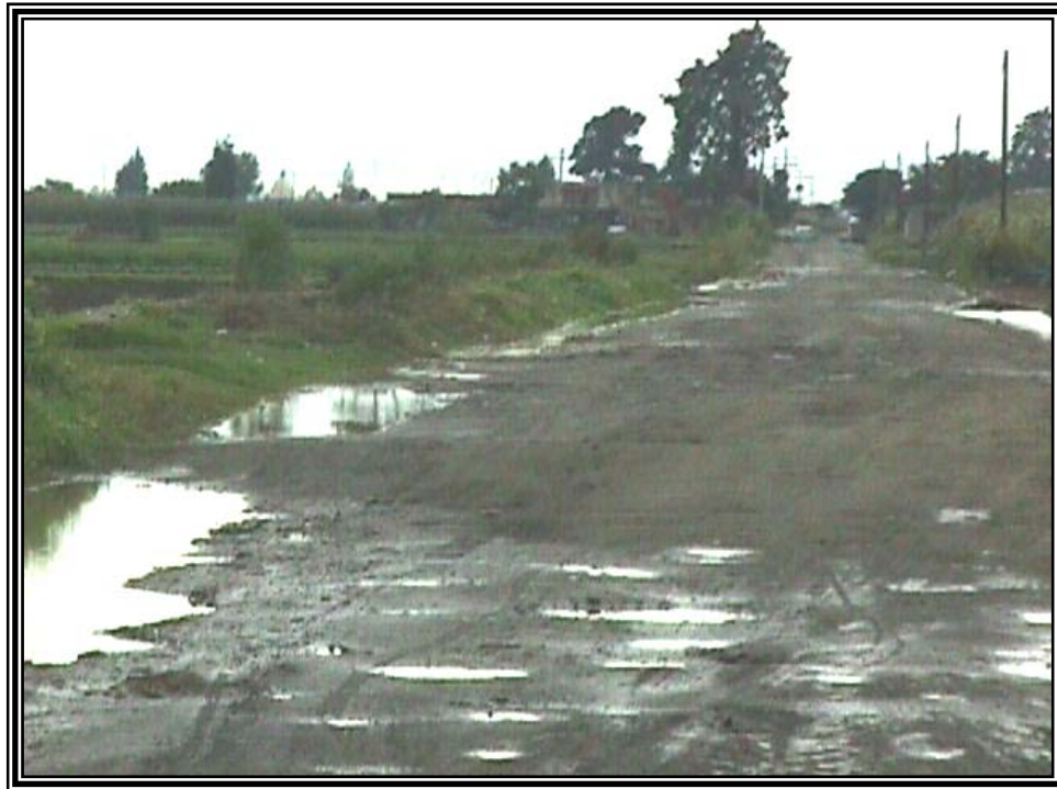
Figura 9. Zona del Km. 1+500 y estado actual.
