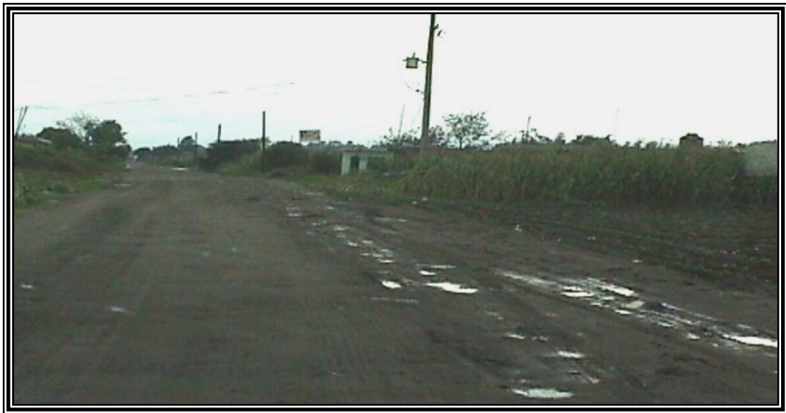
Figura 6. Vía de comunicación a mejorar.
