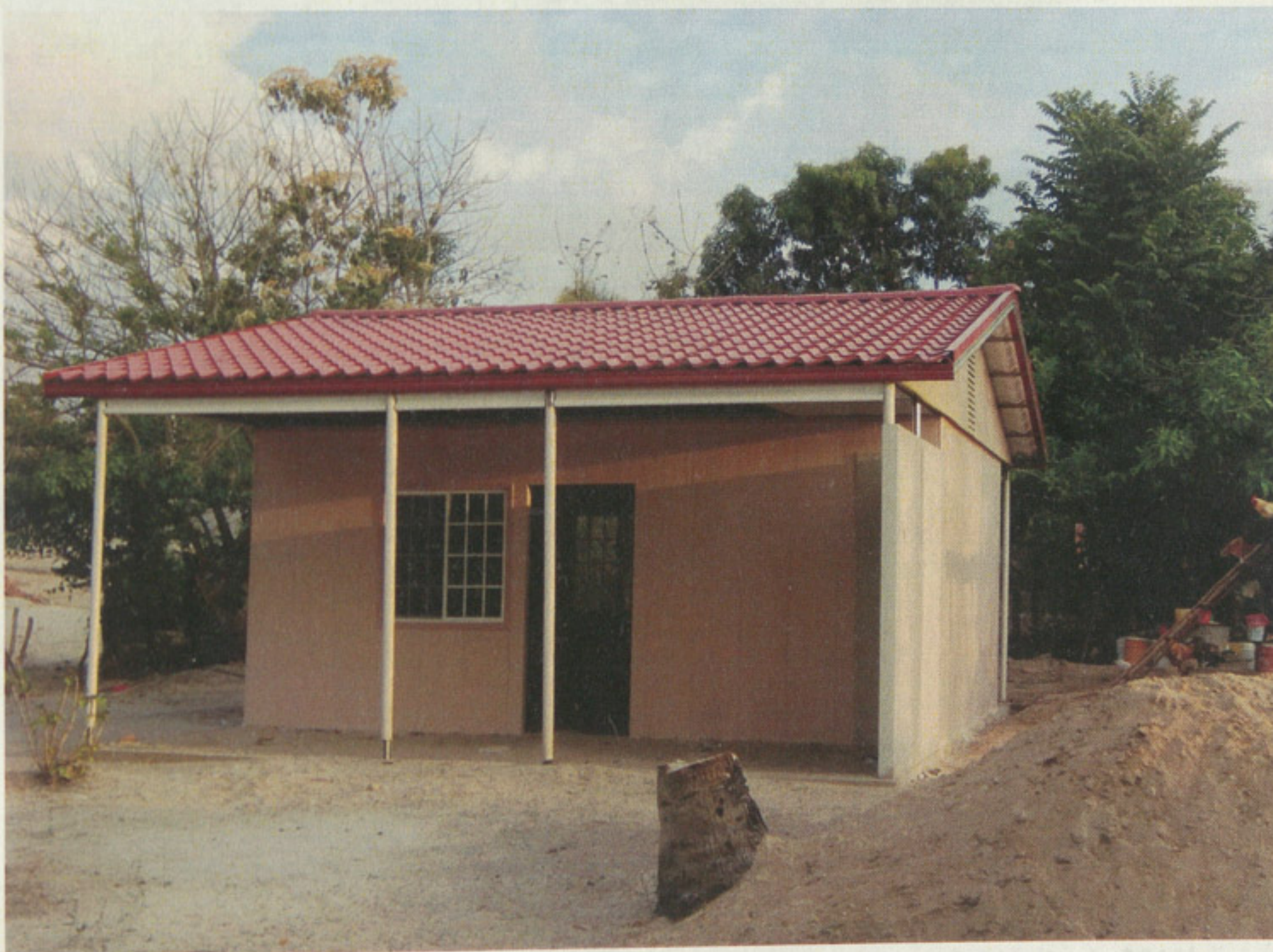
Figura 2 Casa prefabricada donación de Gobierno del Estado hecha de aluminio, plástico, lamina. Archivo personal MAL (junio 2012)
