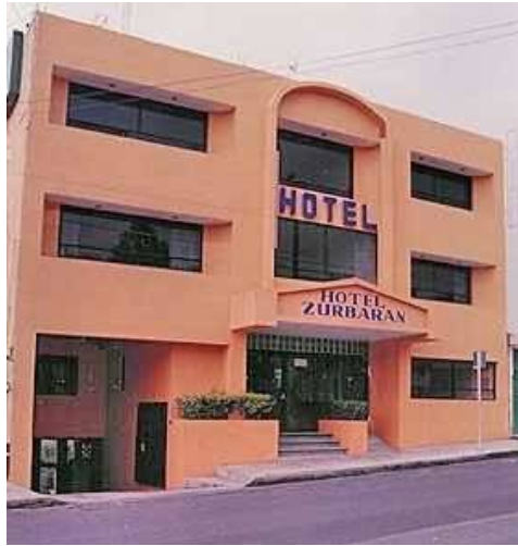
Figura 53. Fachada Hotel Zurbaran.
