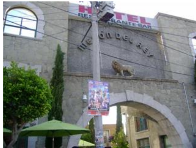
Figura 39. Fachada de Hotel Mesón del Rey
