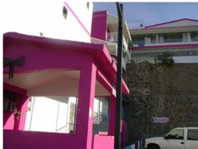
Figura 38. Vista Hotel de La Loma
