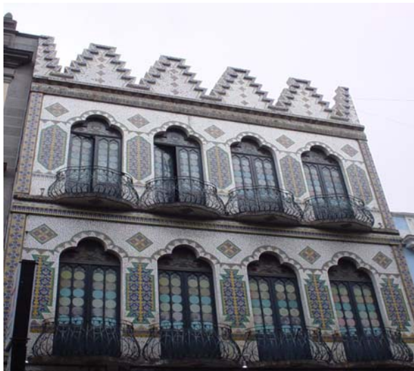
Foto 14. Vista de los balcones Tomada por: Nadia López
