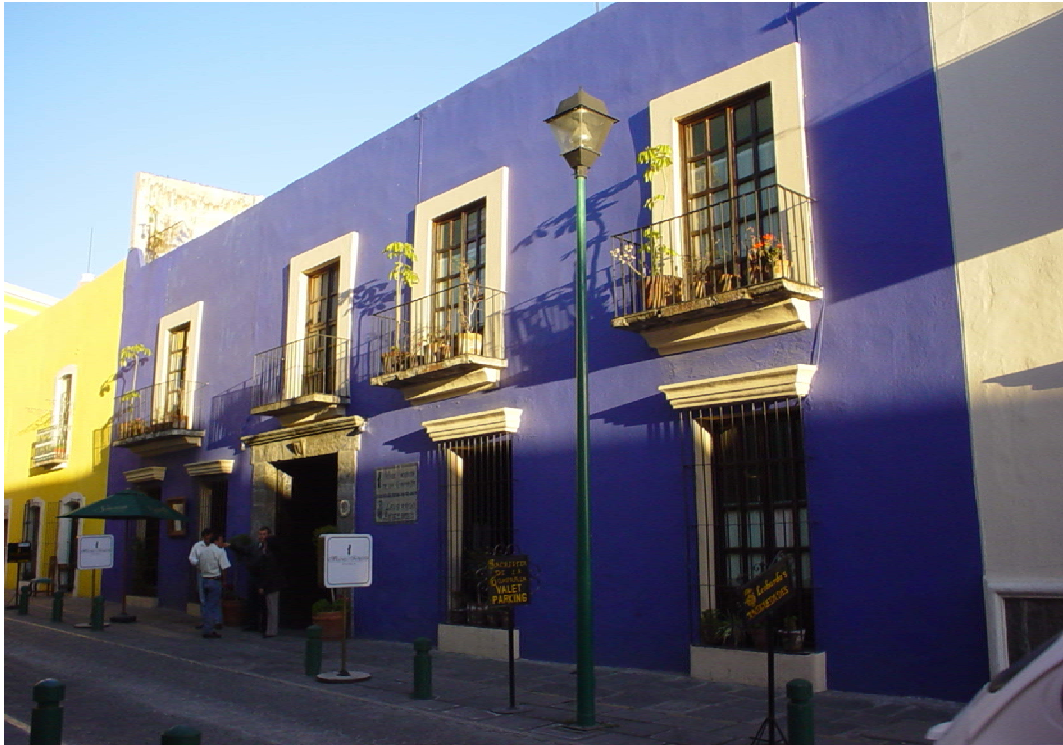
Foto 1. Fachada principal del Hotel Mesón de la Sacristía. Modulación entre vano y macizo, balcones aislados típicos del siglo XVII. Jambas y dinteles del siglo XVIII. Tomada por: Nadia López
