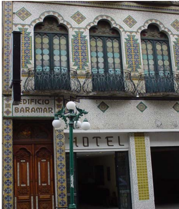
Foto 13. Acceso principal Tomada por: Nadia López
