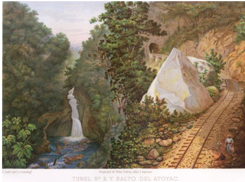
Figura 6.2.7 Túnel No. 2 y Salto del Atoyac.
