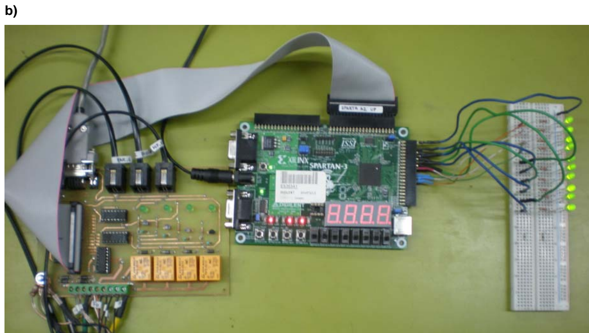
FIGURA 8.8b – (a) Conexión entre el puerto de expansión A2 de la tablilla Spartan3 y el puerto de 40 pines de la interfaz de control por medio de cable plano. (b) Interconexión del sistema de control.
