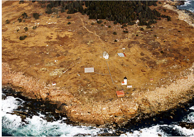
Figura 2.6 Vista área de la isla [MAI02].
