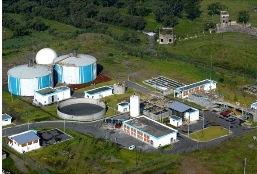
Fig 10.14 Vista aérea de la Planta Atoyac Sur
