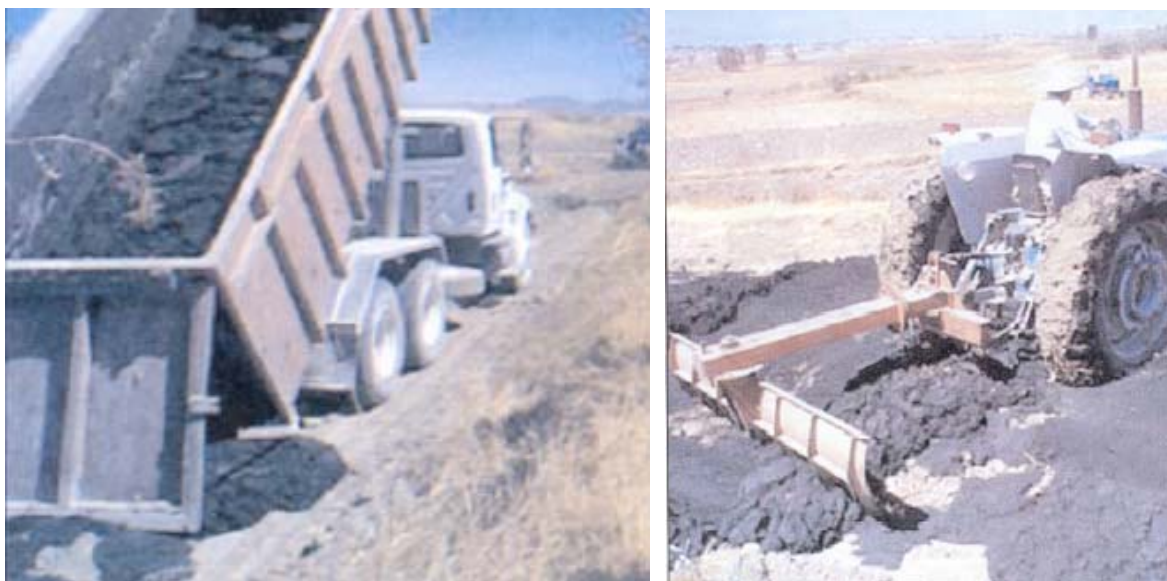
Fig. 10.15 Vista del proceso de aplicación de lodos a terrenos agrícolas
