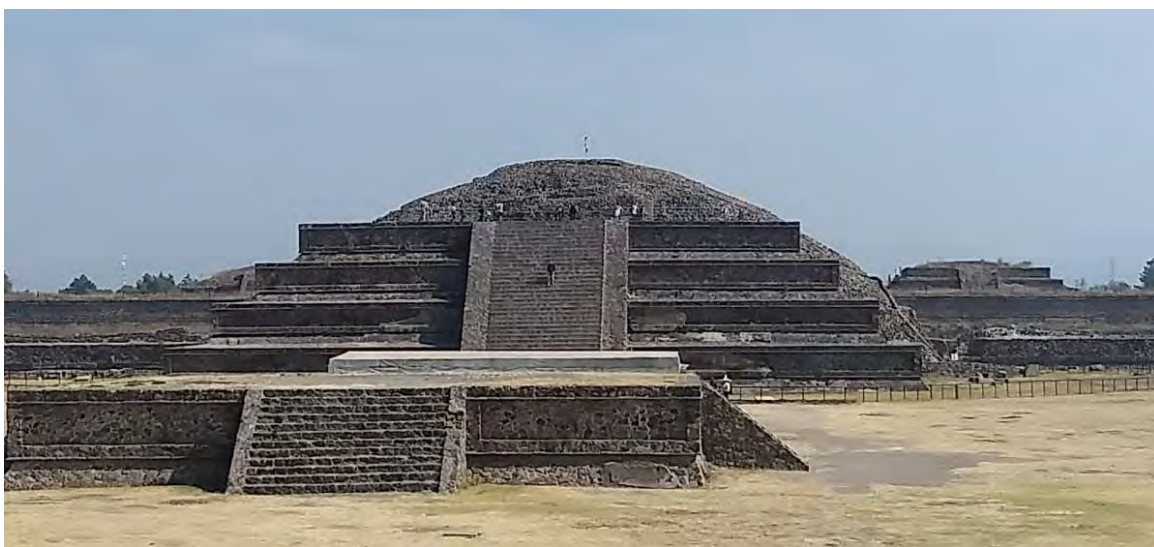
Figura 3. Horizontalidad de los edificios teotihuacanos.
