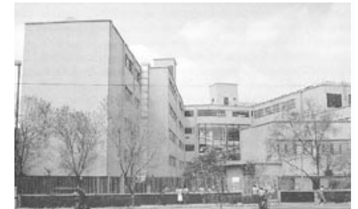
Hospital de Cardiología construido por José Villagrán García en 1937.
