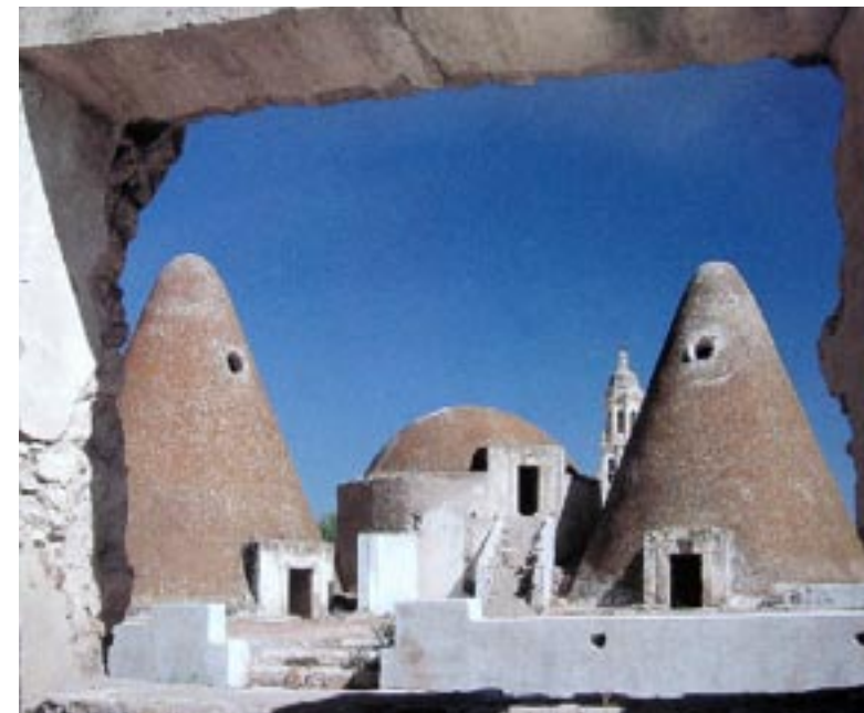
Las torres troncocónicas de la Fábrica Chrysler construidas por Legorreta, asemejan silos, como éstos de la hacienda Jaral de Berrio, en Guanajuato.
