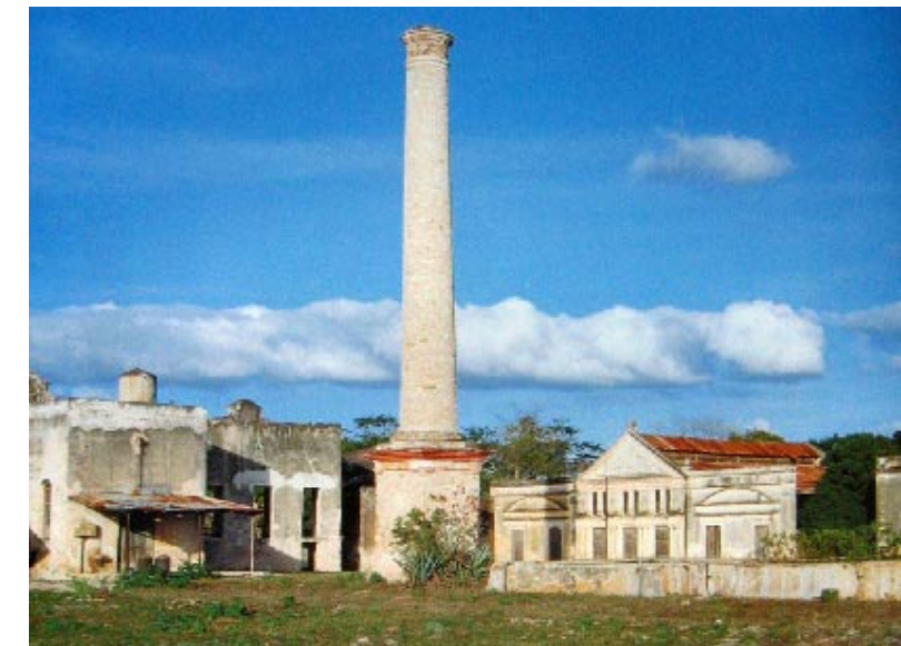
Las construcciones de las haciendas seguían un eje horizontal, roto esporádicamente por elementos verticales, como esta chimenea de la hacienda Yaxcopoil en Yucatán. Esta yuxtaposición de ejes visuales se puede observar también en Solana.
