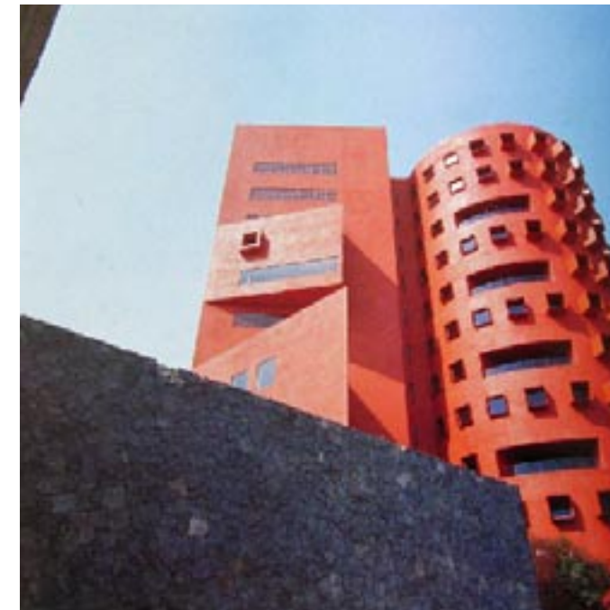
Torre de Administración e Investigación del CNA. Ciudad de México, 1994.
