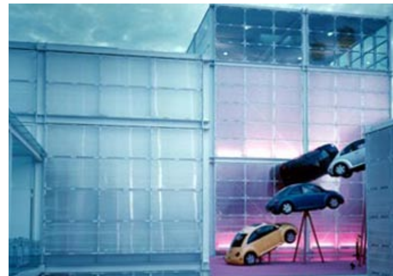
Distintos ángulos y vistas del Pabellón de México.
