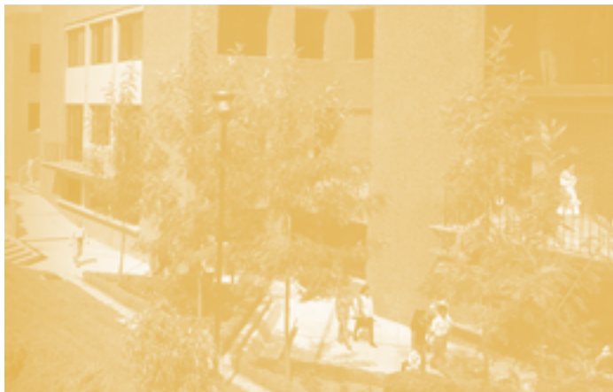
Edificio de la Biblioteca completamente terminado en su tercer piso , 1978.
