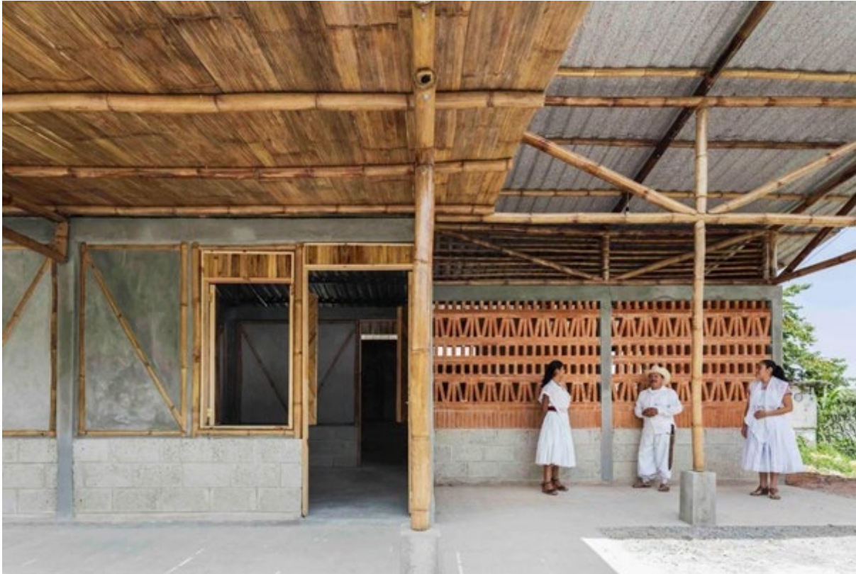
Comunal Taller de Arquitectura . Vivienda en Puebla | Foto: Onnis Luque, Archdaily | 2016
