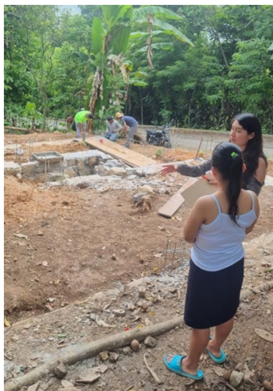
Proceso cimentación casa Margarita | Foto: Equipo Landlab | 2024
