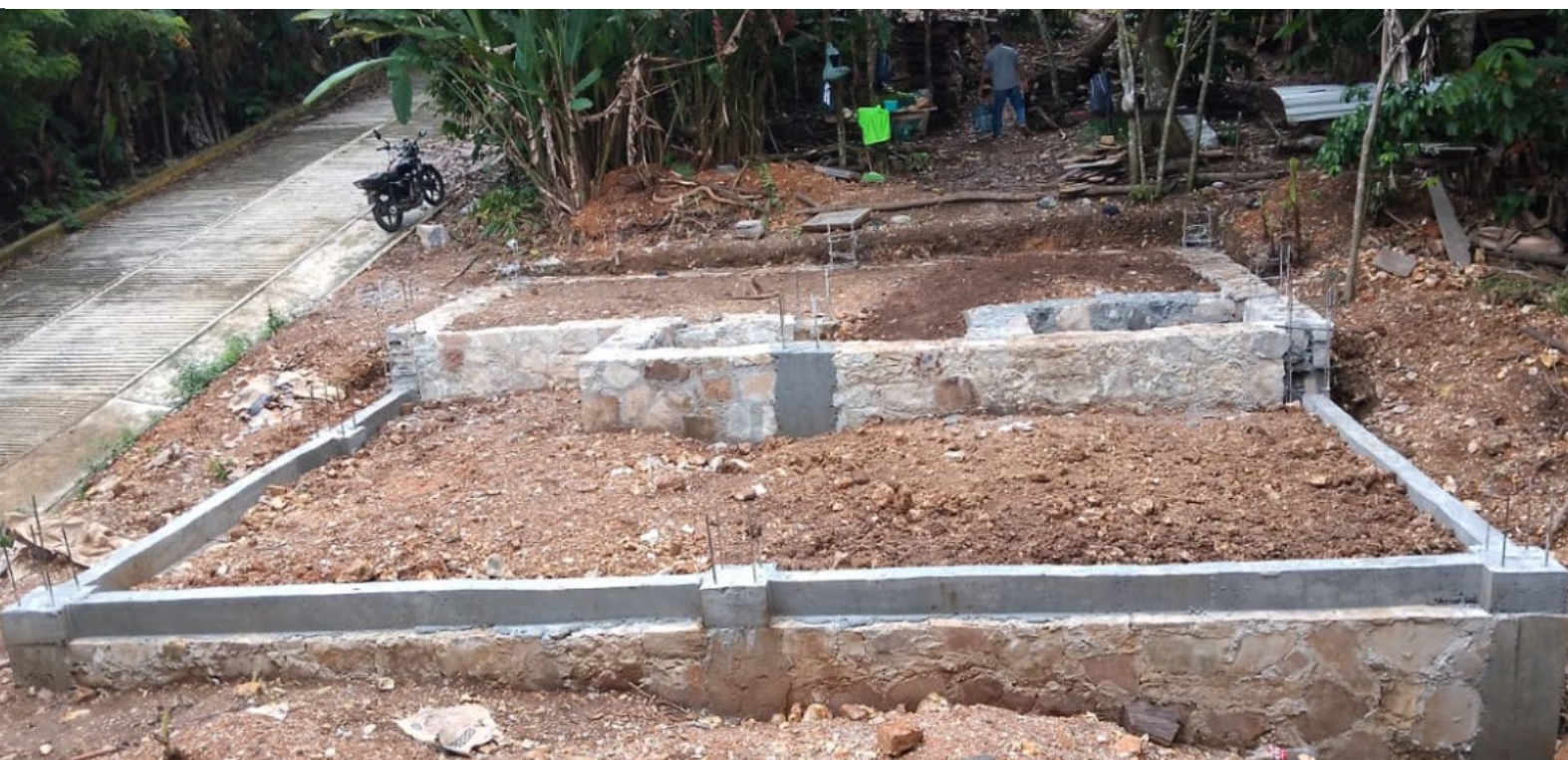
Fase 1: Cimentación (Estado actual) | Equipo Landlab | 2024
