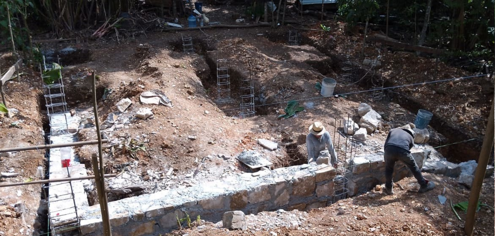
Comienzo proceso constructivo: Cimentación de piedra | Equipo Landlab | verano 2024
