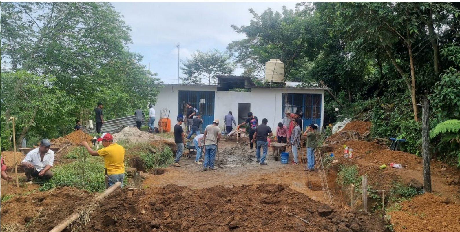
Faena para cimentación | noviembre 2024 | Foto: Equipo Landlab | nov 2024
