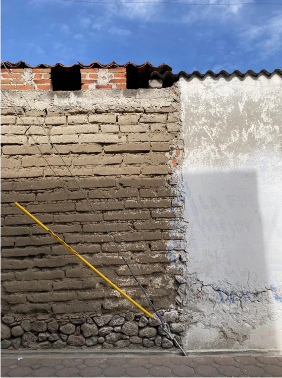
Figura 8. Collage de procesos de construcción. © Angela, T.P. (2022) Sustitución de materiales y procesos regionales por industrializados y prefabricados – muro que solía ser de adobe ha sido complementado por ladrillos y bloques industrializados, amalgamamiento de procesos tradicionales con actuales. ¿Los procesos vernáculos y regionales no han sido consumidos por completo?
