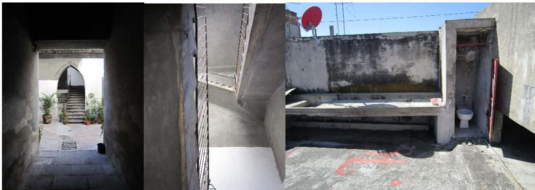
Imagen 30: Vistas tercer patio, escaleras acceso a azotea.
