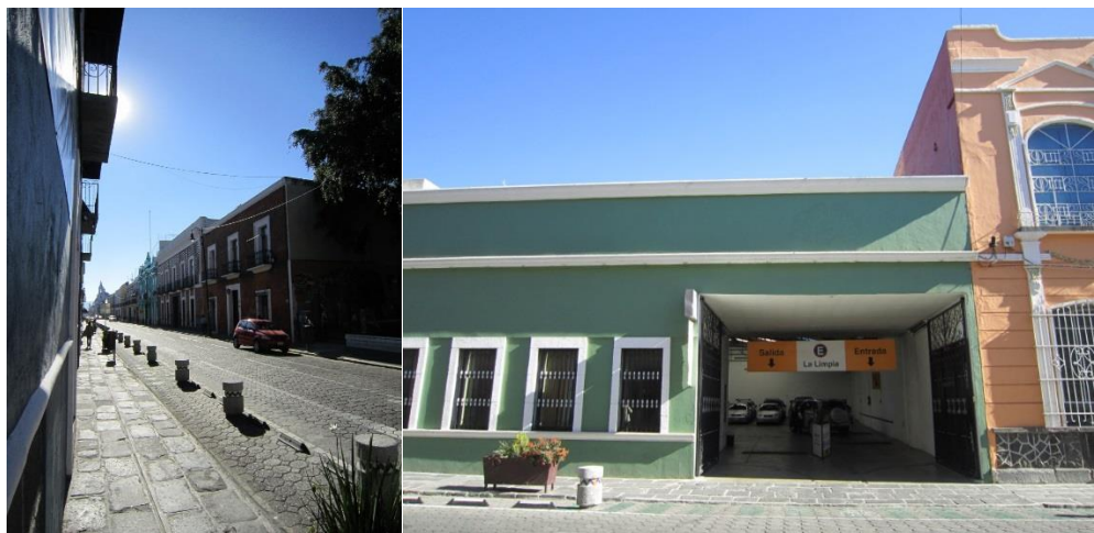
Imagen 18: Vistas fachadas calle 7 Poniente Centro Histórico Puebla.
