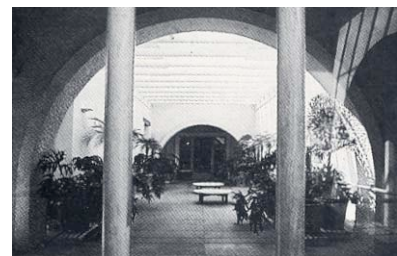
Se abrieron vanos para iluminación natural
