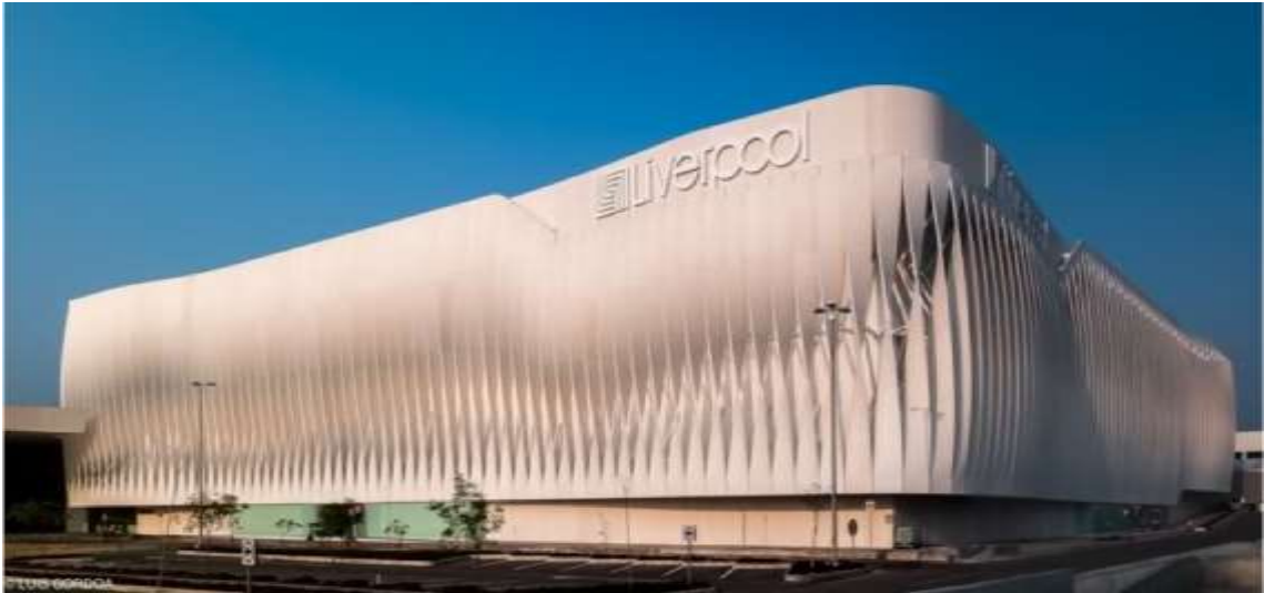
Imagen C36: Fachada de concreto en forma de hélices. (fuente: www.archdaily.mx )
