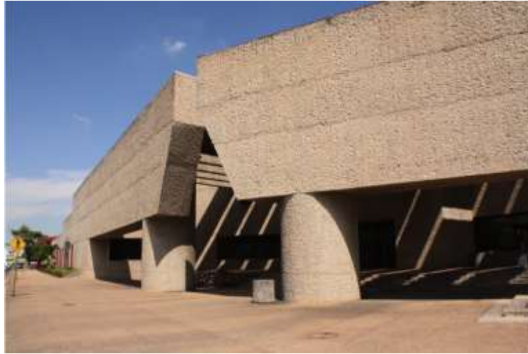
Imagen C37: Fue diseñada por Teodoro Gonzáles de León y J. Francisco Serrano. (Fuente: www.franciscoserranoarquitecto.com )
