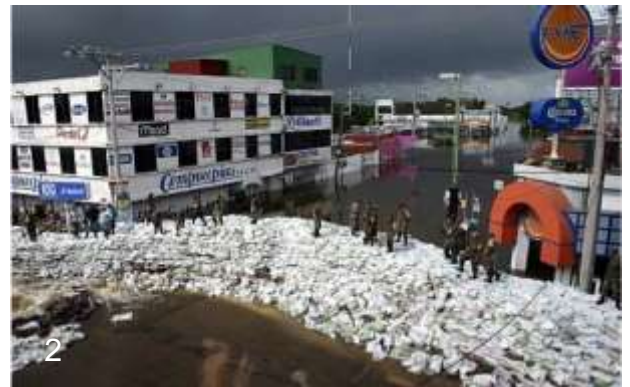
Imagen C35: 1 Av. Gregorio Méndez inundada a 2.5m de altura aprox. 2 Muro de costales sobre Av. Ruiz Cortínez. (fuentes: www.bolainez.org y www.jhproducciones.blogspot.mx )
