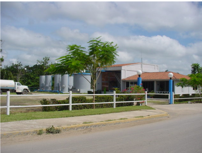
Planta de Captación de Agua, ubicada al lado Norte del Río
