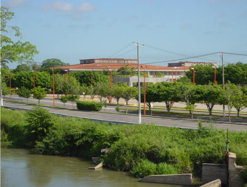
El complejo de PEMEX, Tabasco 2000, se encuentra en la esquina sur del río, frente al terreno destinado al paseo.
